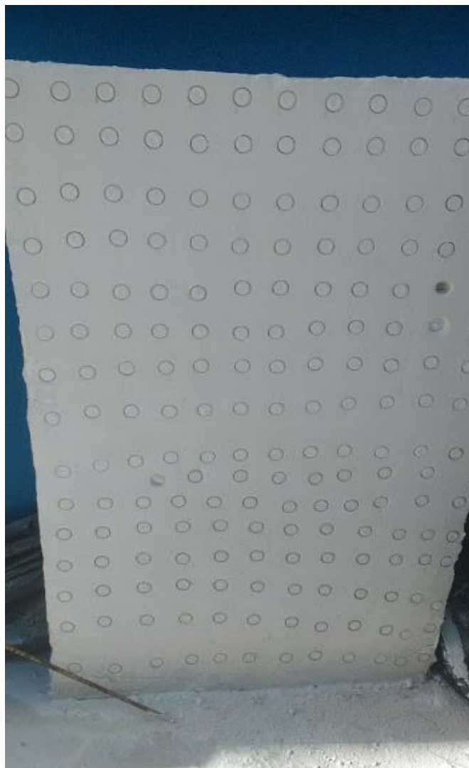
Figura 27 – Bloco de concreto estrutural com revestimento todo cortado. Fonte: Autor.
