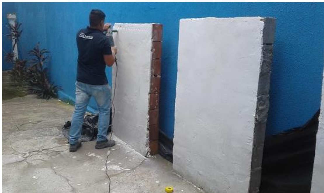
Figura 26 – Corte do revestimento utilizando uma serra copo. Fonte: Autor.
