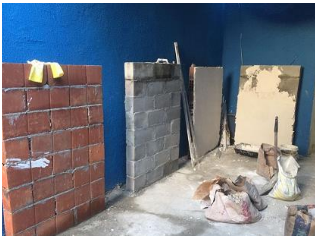
Figura 18 – Vista geral das bases. Fonte: Autor.
