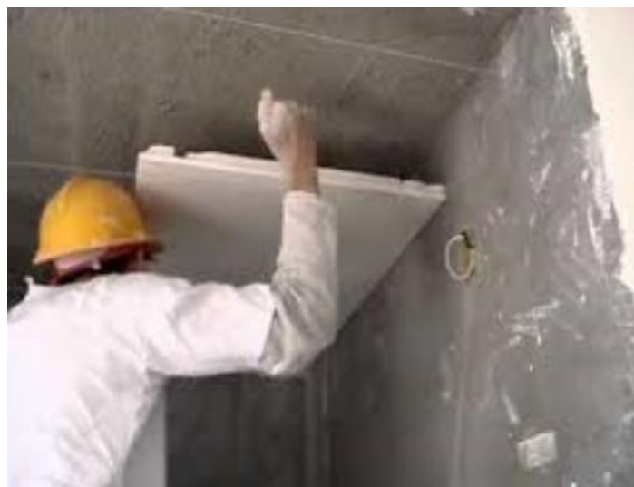
Figura 7 – Gesso cola sendo usado para fixação de placa. Fonte: Site Brazilian Gypsum.
