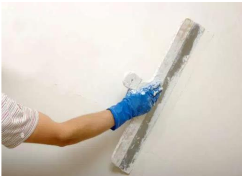
Figura 4 – Aplicação de gesso em pasta. Fonte: Site Gesso Elegance.
