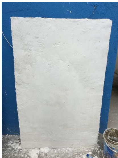
Figura 19 – Bloco de concreto estrutural revestido com gesso. Fonte: Autor.
