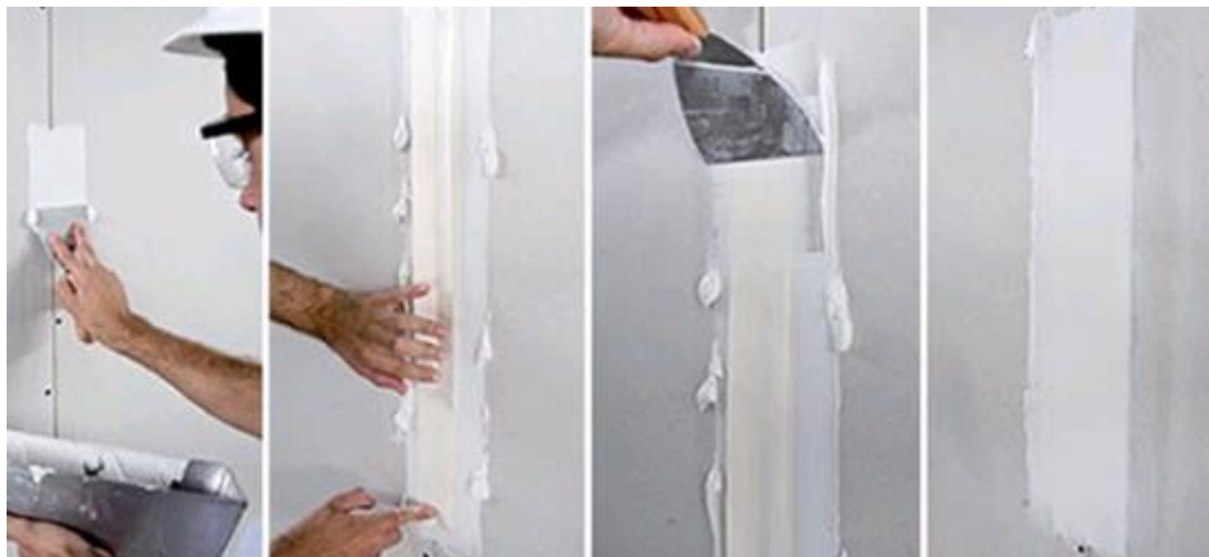
Figura 8 – Massa de gesso sendo usada para reparos. Fonte: Site Fórum da Construção.
