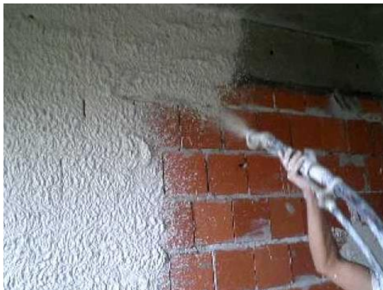
Figura 5 – Aplicação de argamassa de gesso em base cerâmica. Fonte: Site Thiel Serviços de Engenharia.
