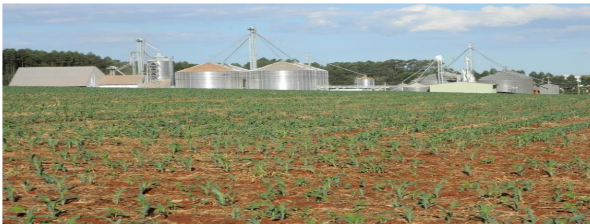
Figura 3 – Silo representando uma estrutura de armazenamento de grãos
