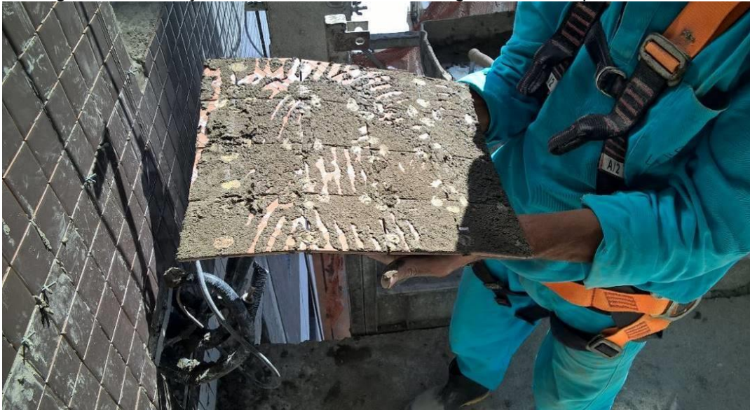
Figura 5 - Verificação em canteiro de obra da colagem efetiva da placa cerâmica.
