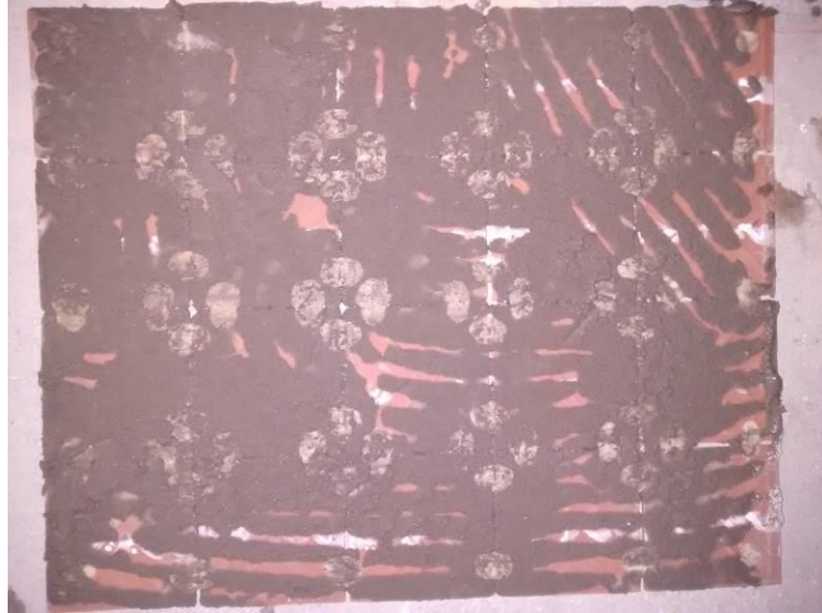
Figura 14 - Placa cerâmica indicando falha no espalhamento da argamassa colante sobre o tardo.
