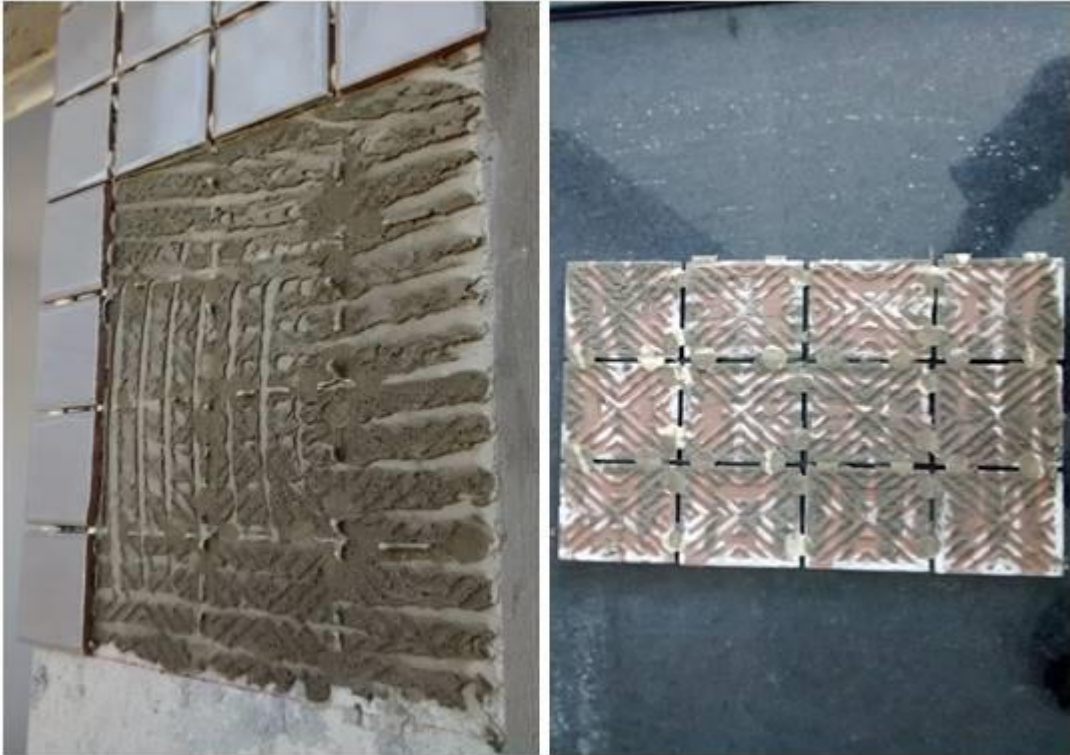
Figura 4 - Falha de colagem em placas cerâmicas aderidas com argamassa colante.
