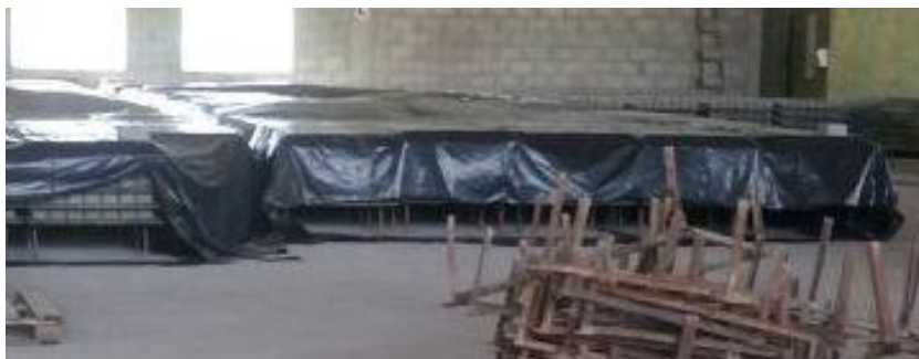
Figura 14. Cura dos pavers com utilização de lona plástica.
