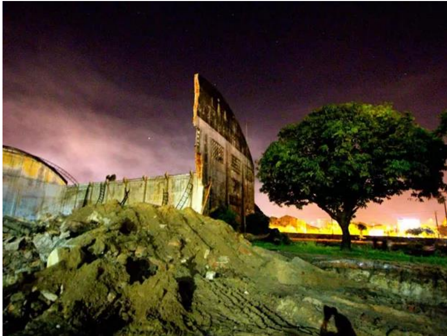
Figura 30 – Demolição dos Armazéns do Cais José Estelita pelo Consórcio Novo Recife em maio de 2014 (Foto: Nilton Pereira / Acervo Pessoal)
