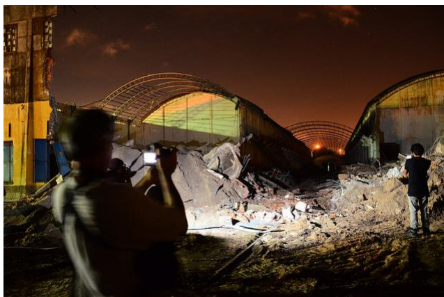
Figura 4: Foto da demolição dos armazéns
