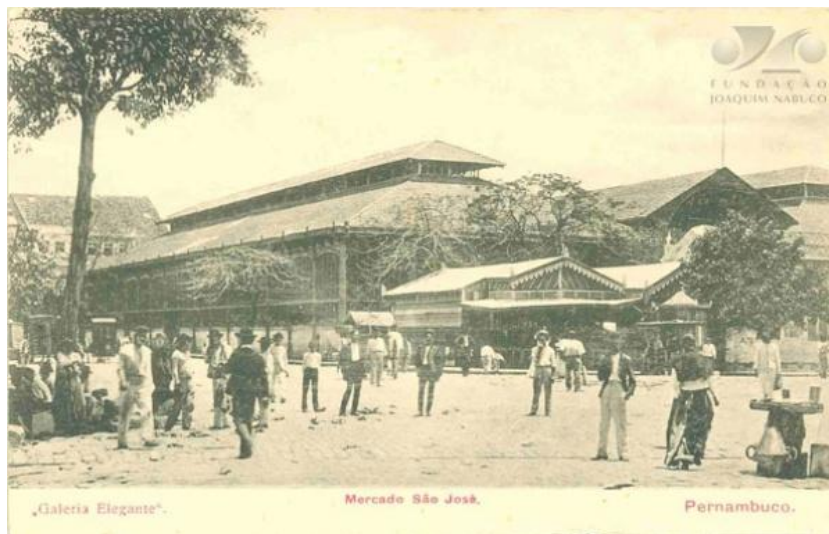
Figura 8 – Mercado de São José: inaugurado em 1875, é o mais antigo edifício de ferro existente no Brasil
