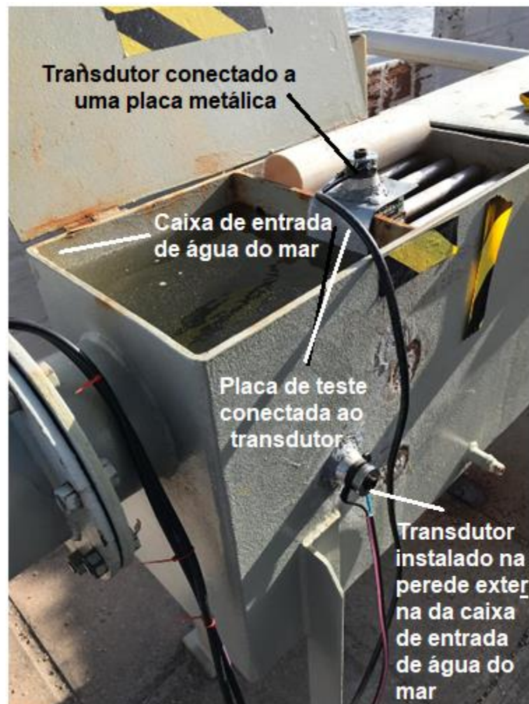
Figura 8 – Transdutores ultrassônicos instalados: um instalado na parede externa da caixa de entrada de água do mar no protótipo de bancada instalado no Catamaran; outro na placa metálica na parte superior da caixa de entrada de água
