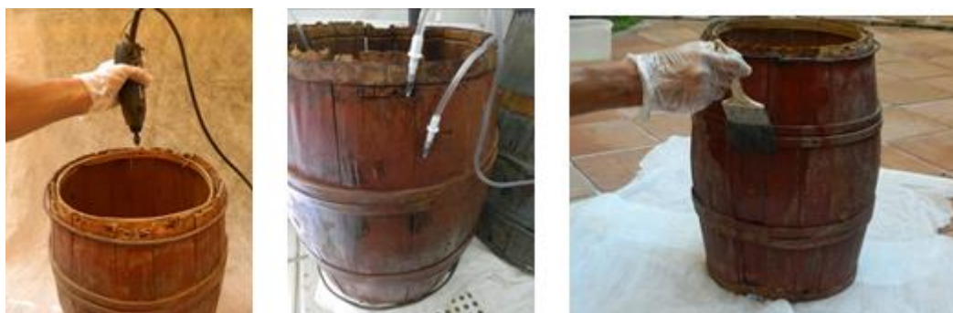
Tratamento de desinfestação/imunização por gotejamento, injeção e pincelamento.
