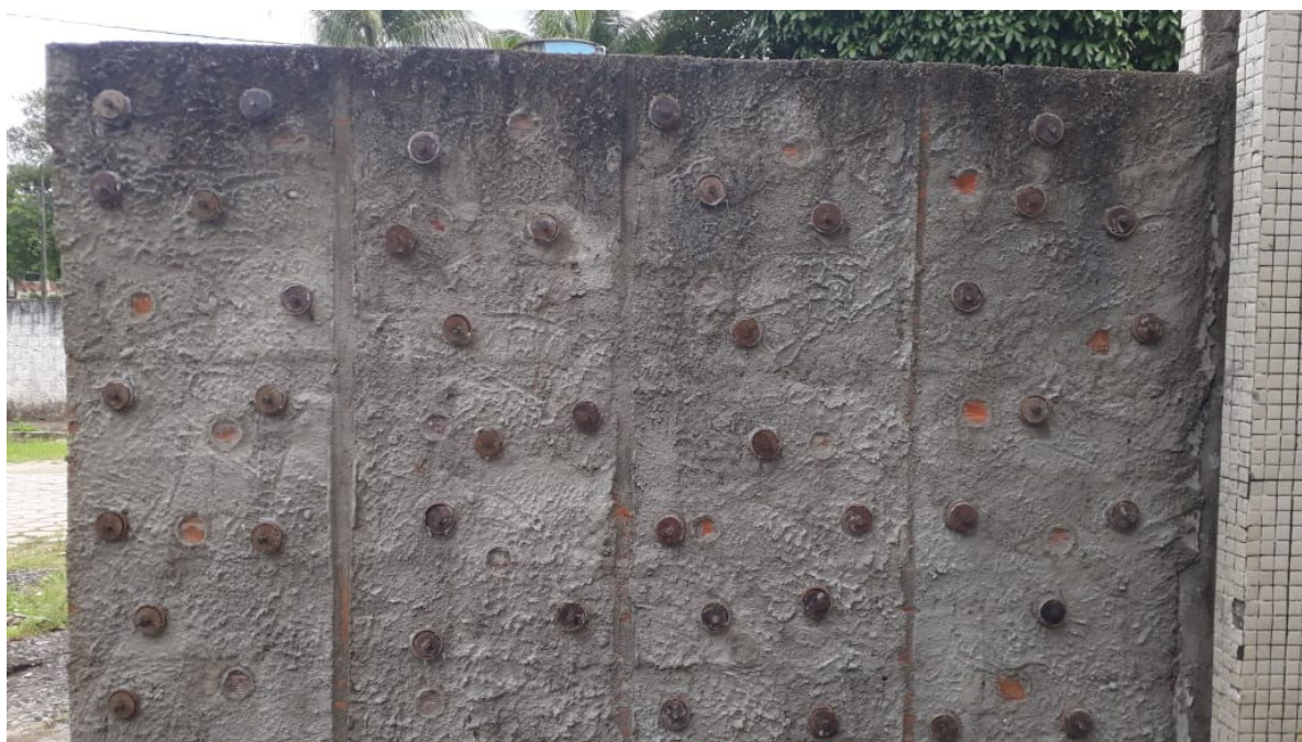
Figura 34 – Parede de alvenaria de blocos cerâmicos executado no ambiente externo do laboratório.
