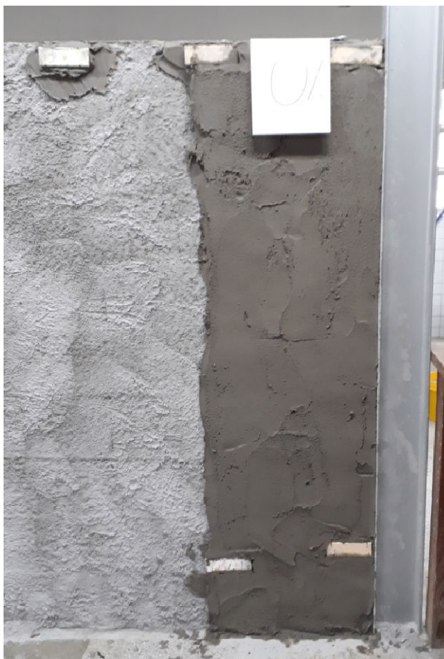
Figura 24-Aplicação do emboço (Blocos cerâmicos)
