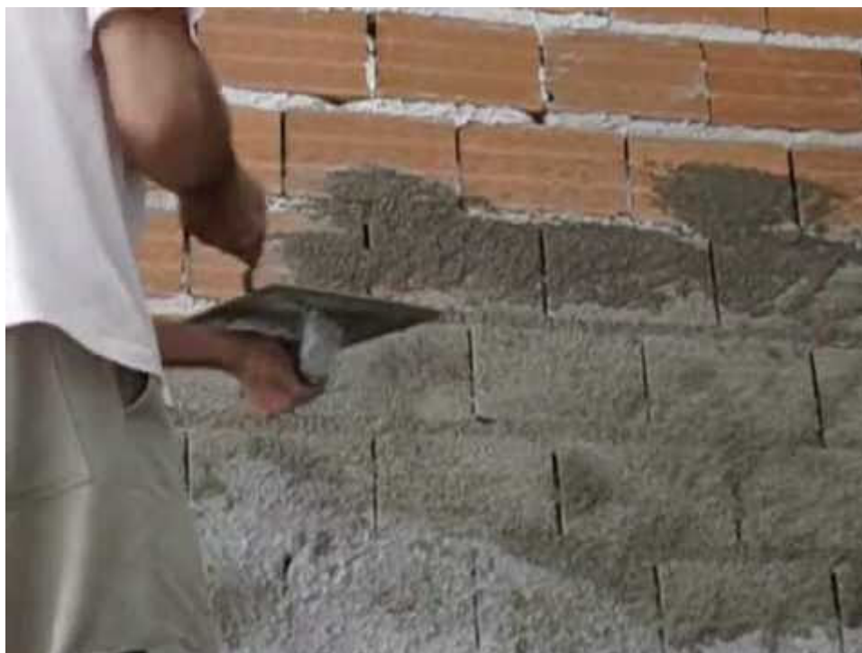
Figura 4 - Aplicação do chapisco tradicional com colher de pedreiro.
