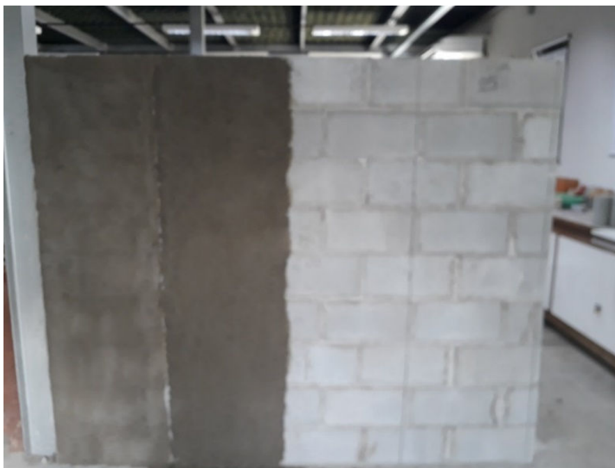
Figura 20 - Parede com blocos de concreto com chapisco com cal.
