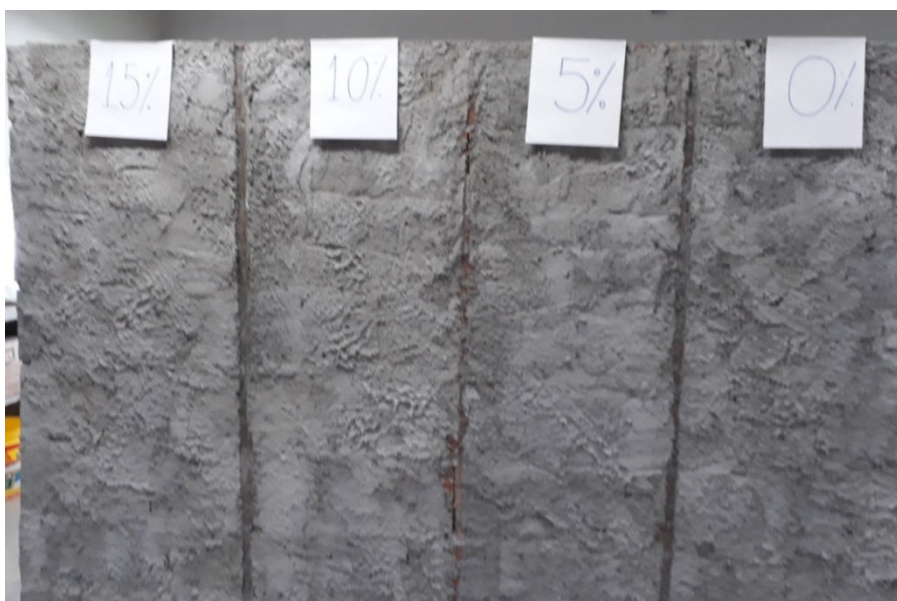
Figura 23-chapiscadas prontas bloco cerâmica.
