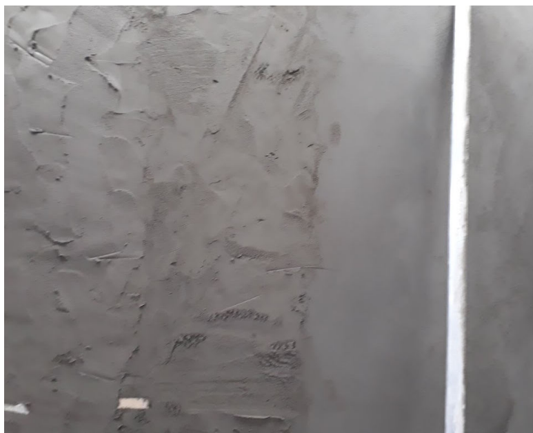
Figura 5 – Vista da etapa de acabamento na execução da argamassa de emboço.
