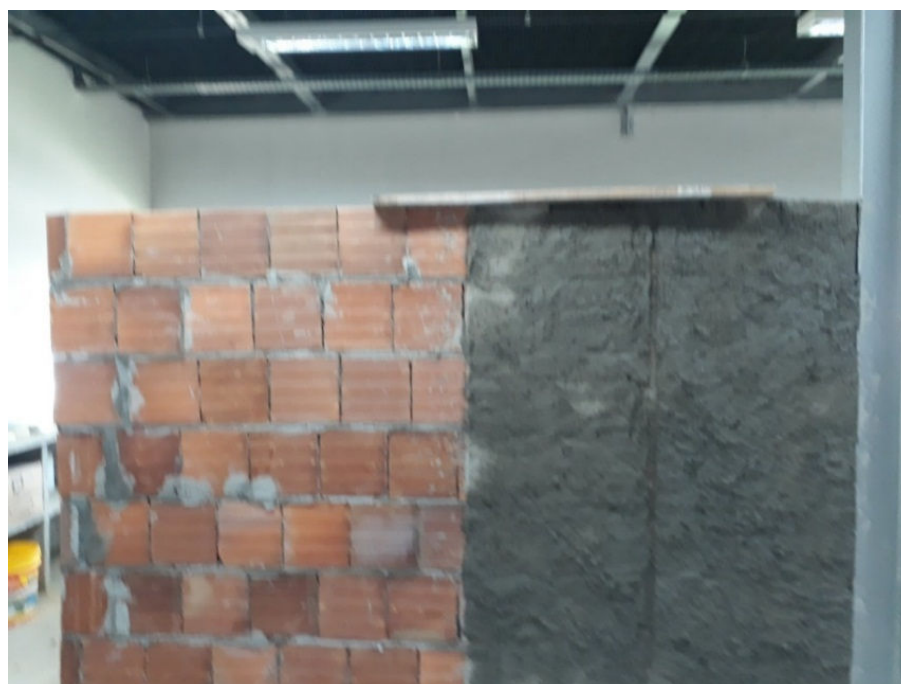
Figura 19 - Parede de blocos cerâmicos sendo chapiscada.
