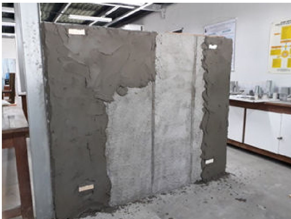
Figura 25 – Vista do painel com bloco cerâmico durante a aplicação da argamassa de emboço
