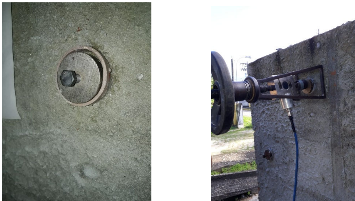
Figura 35 – Colagem da peça metálica sobre o chapisco (esquerda) e posicionamento do aderímetro (direita).
