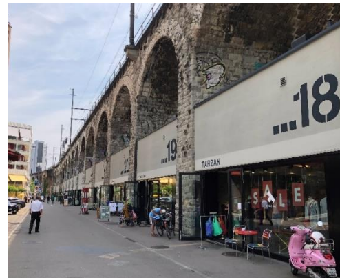
Fig.17 - Im Viadukt, Zurique
