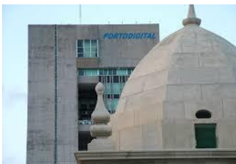
Fig.100 – Edf. Vasco Rodrigues, sede do NGPD (antigo BANDEPE)
