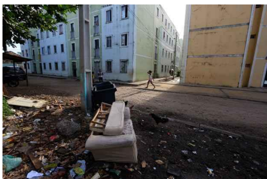
Fig.106 – conjunto habitacional no Pilar
