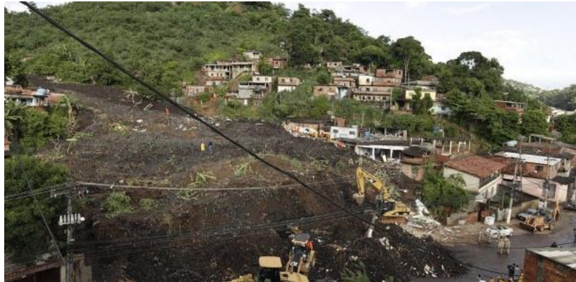
Figura 5 – Deslizamento no Morro do Bumba (Niterói, RJ)
