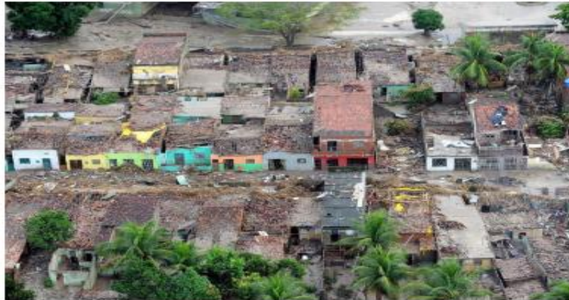
Figura 8 – Casas destruídas após inundações
