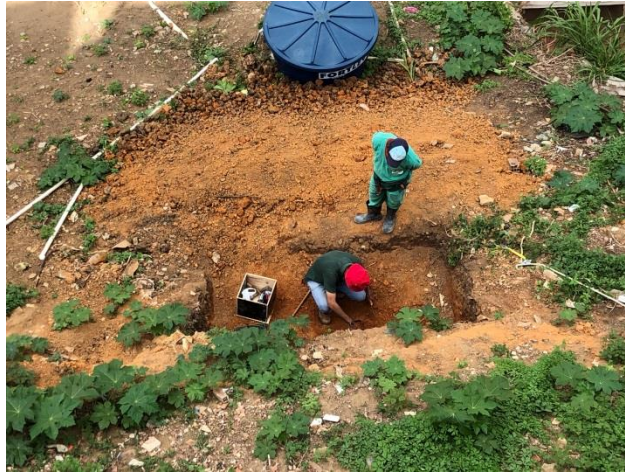
Figura 36 – Poço de investigação
