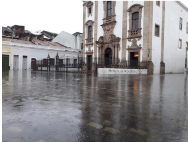
Figura 10 – Pátio de São Pedro alagado (Centro do Recife)
