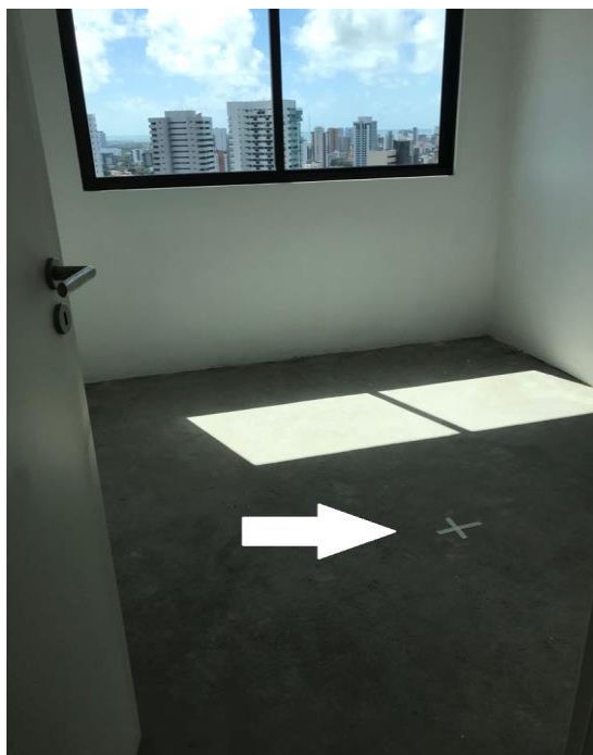
Figura 13 - Posição do centro geométrico materializado no chão com fita adesiva.
