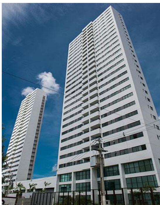
Figura 8 – Edifício Residencial Avaliado
