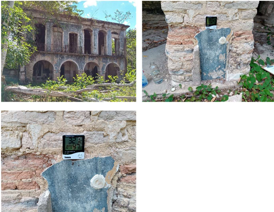
Figura 27 -Local de Fixação do tubo de Karsten na Casa – Grande
