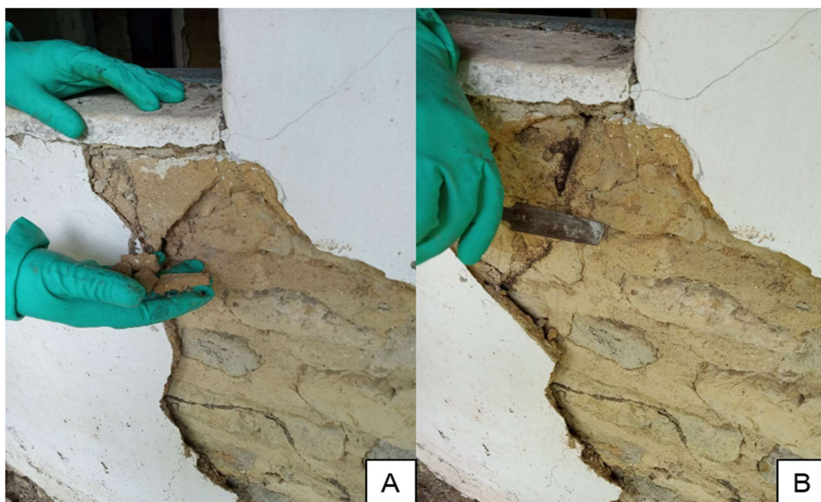
Figura 11 - Coleta de argamassas de revestimento (A) e de assentamento (B) da Senzala do Engenho Monjope – PE
