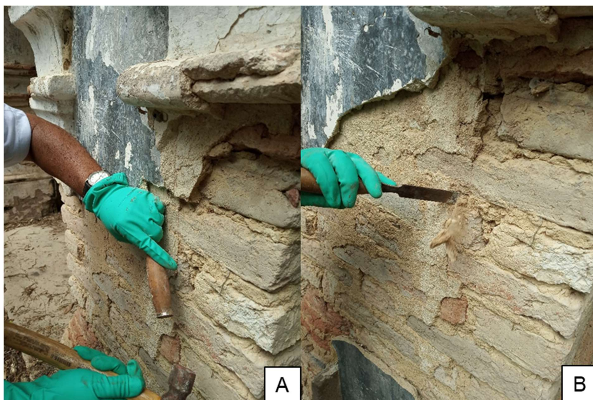
Figura 09 - Coleta de argamassas de revestimento (A) e de assentamento (B) da Casa Grande do Engenho Monjope- PE
