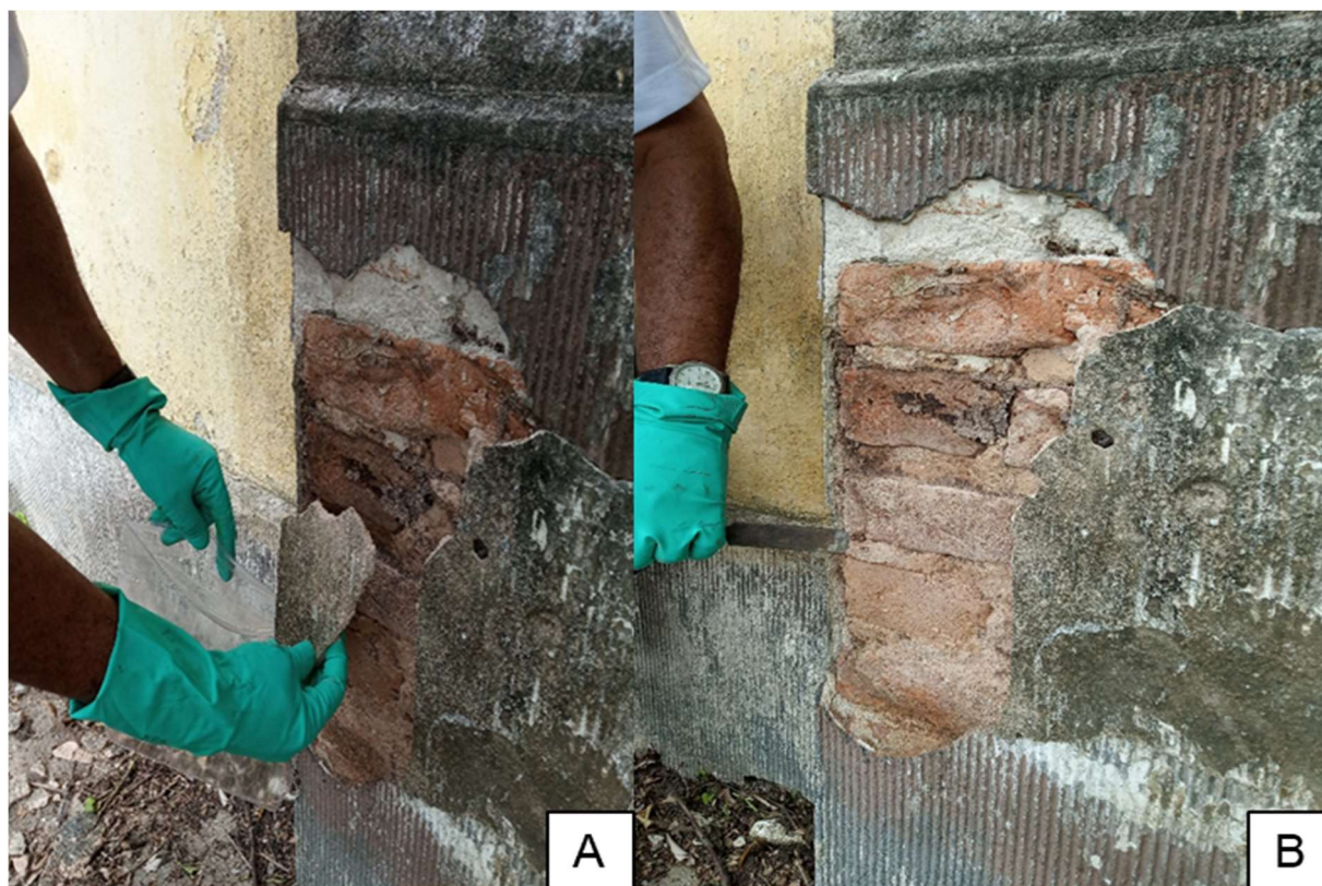
Figura 10 - Coleta de argamassas de revestimento (A) e de assentamento (B) da Capela do Engenho Monjope- PE
