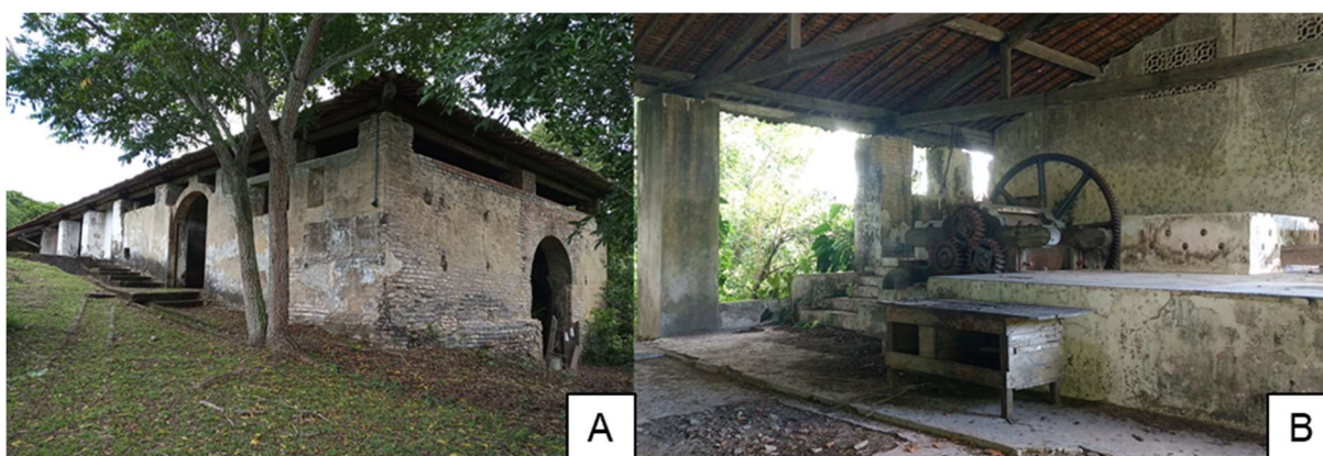
Figura 00-7 - Fachada da fábrica do Engenho Monjope (A) e engrenagens que movem a roda d'água (B).
