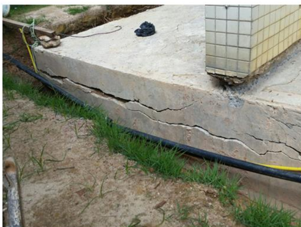
Figura 1.3 - Fissura horizontal de grande abertura em bloco de coroamento de estacas, Silva (2017)
