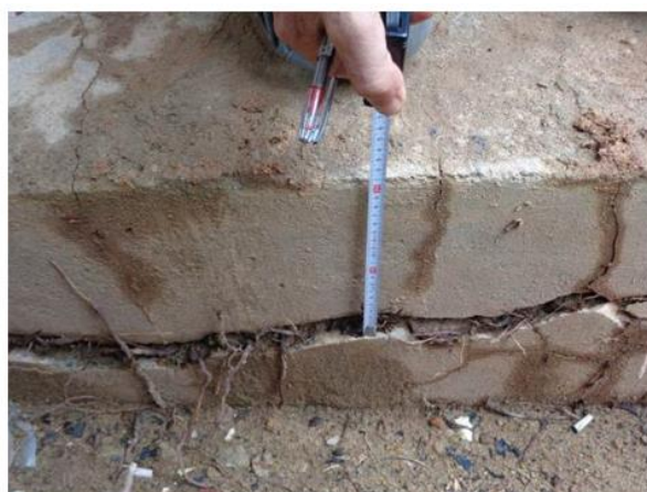
Figura 1.4 - Vista detalhada de fissura horizontal em blocos de coroamento de estacas, Silva (2017)
