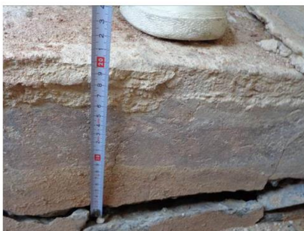
Figura 1.4 - Vista detalhada de fissura horizontal em blocos de coroamento de estacas, Silva (2017)
