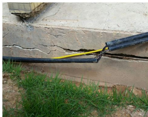
Figura 1.3 - Fissura horizontal de grande abertura em bloco de coroamento de estacas, Silva (2017)
