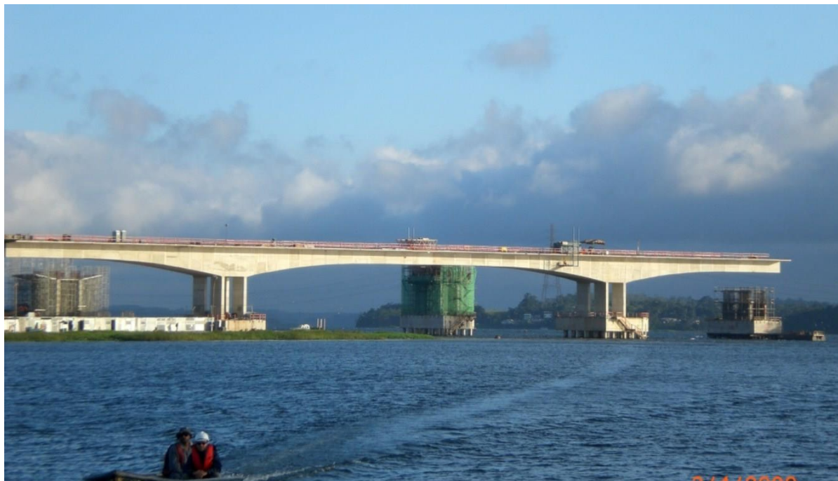
Figura 1 – Ponte em concreto armado e protendido sobre represa Billings, SP
