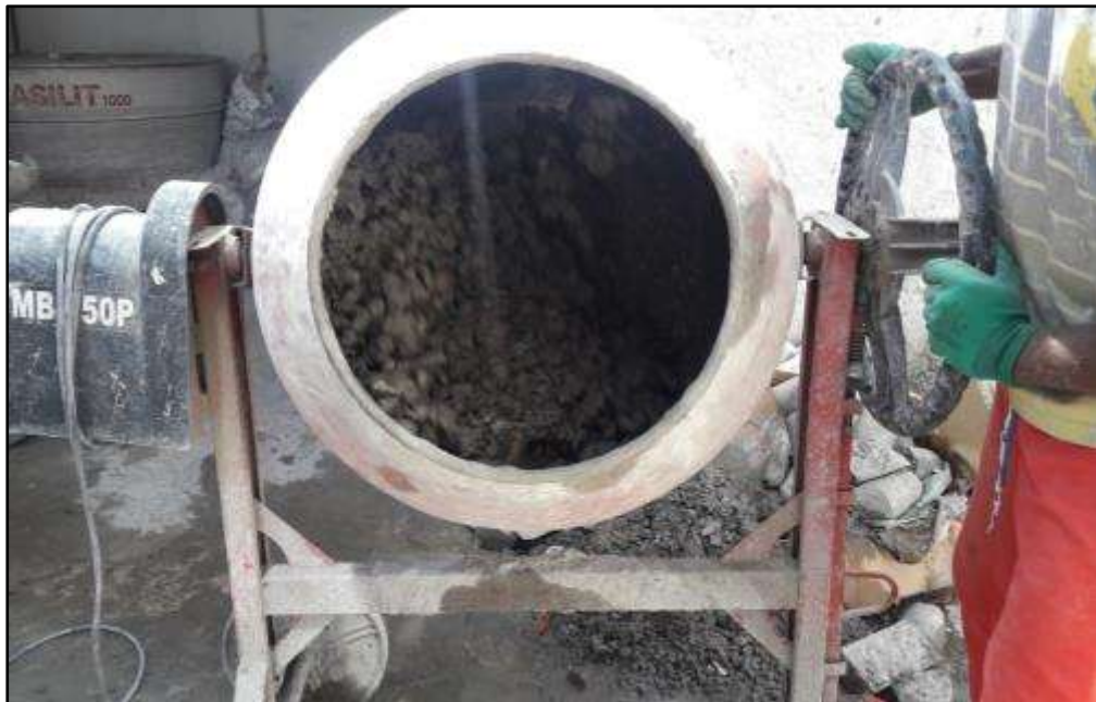
Figura 21: Mistura do concreto em betoneira
