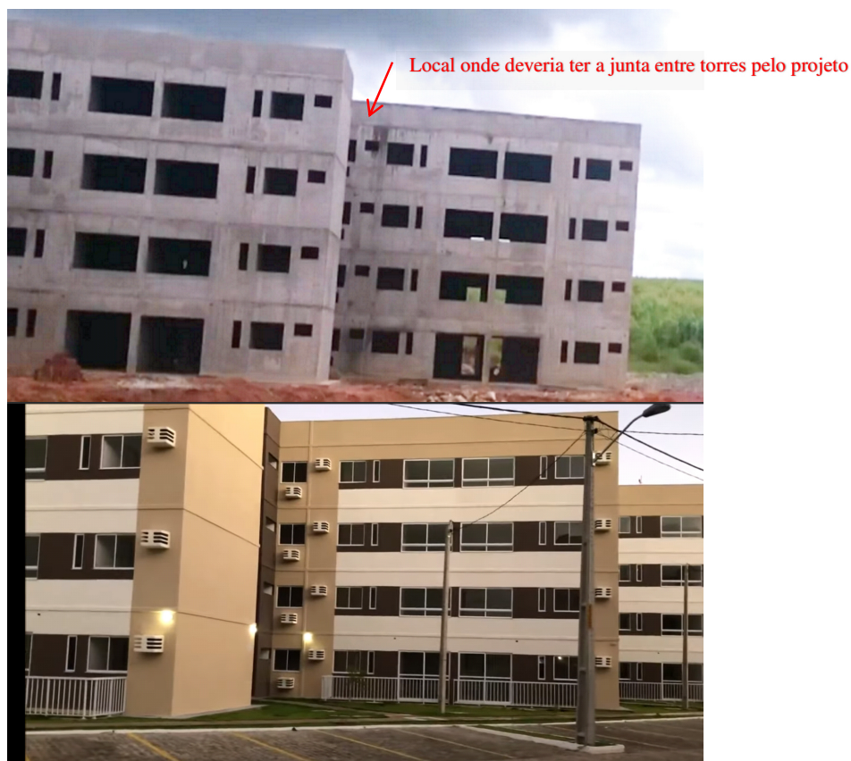
Figura 147 - Registro fotográfico do imóvel I-13 nas fases de execução da obra e entrega
