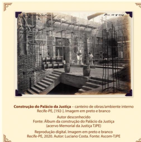
Figura 1 - Construção do Palácio da Justiça
