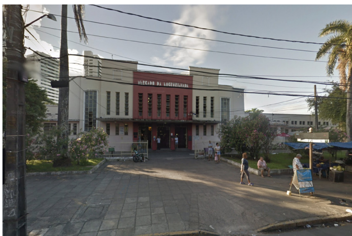
Figura 5. Fachada do Mercado da Encruzilhada, Recife - PE.
