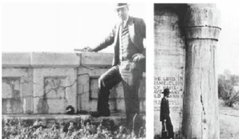
Figura 7 – Foto histórica de Stanton em estrutura comprometida pela RAA.
