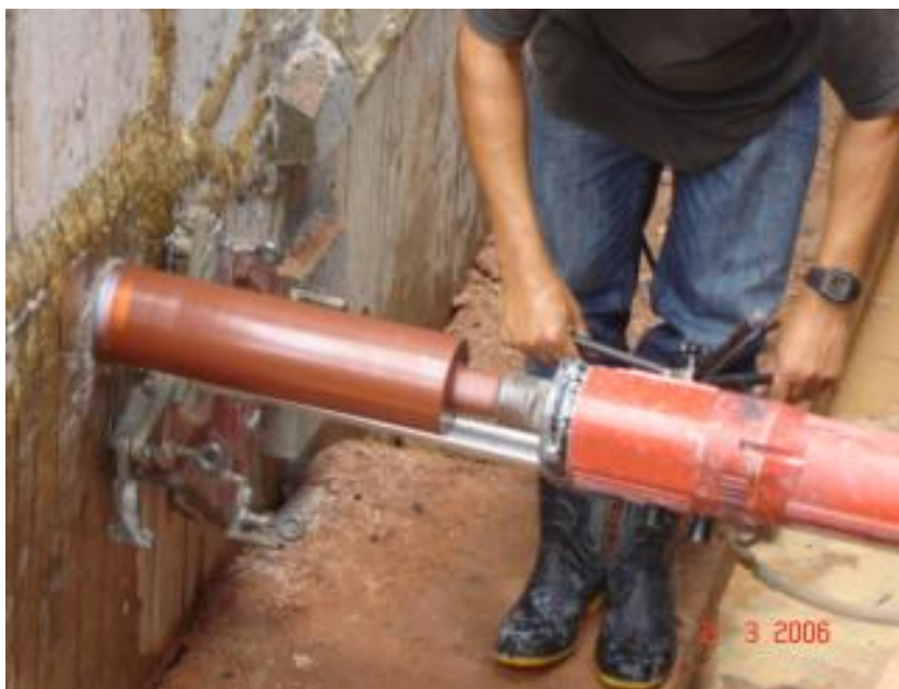
Figura 35 - Retirada de corpos-de-prova para análise laboratorial
