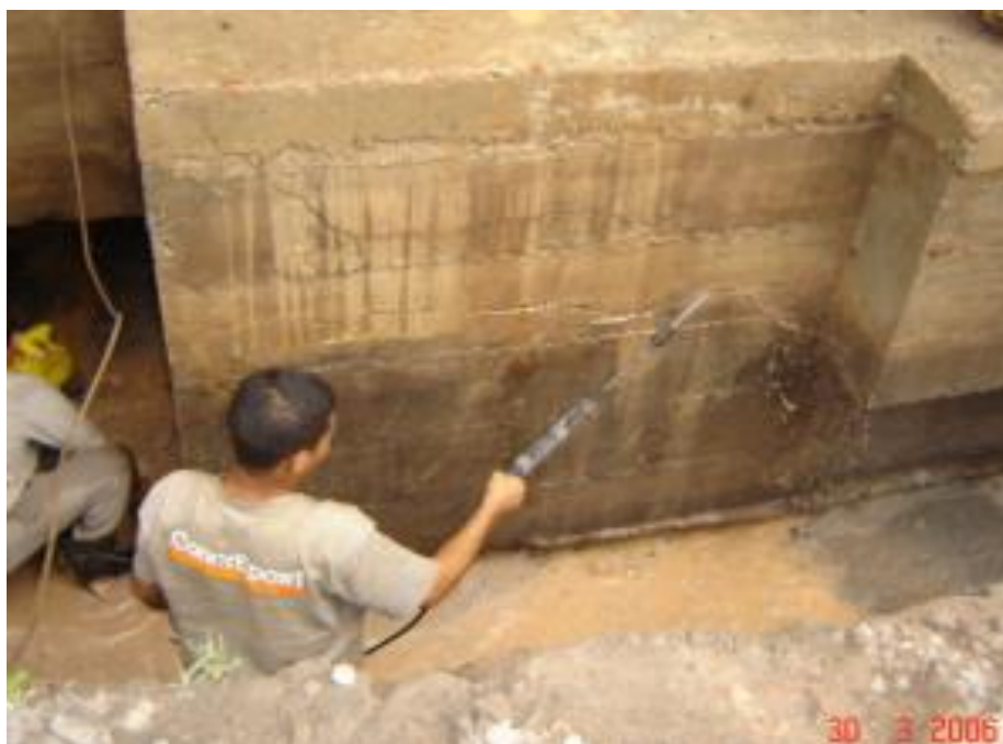
Figura 31 - Lavagem das faces com a lavadora de alta pressão
