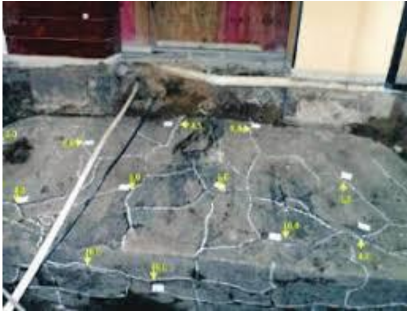
Figura 34 - Mapeamento das lesões
