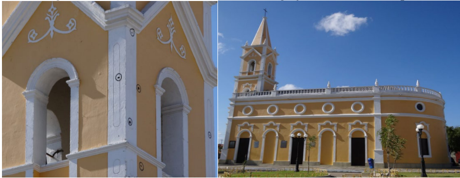
Figura 17 - Marcas dos tiros na torre da Igreja e lateral do templo.
