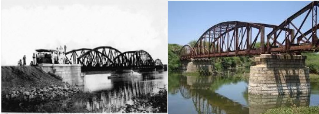
Figura 14 - Ponte da linha Férrea em Mossoró em 1917 e em 2021.
