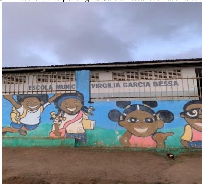
Figura 34 – Escola Municipal Virgília Garcia Bessa localizada na comunidade
