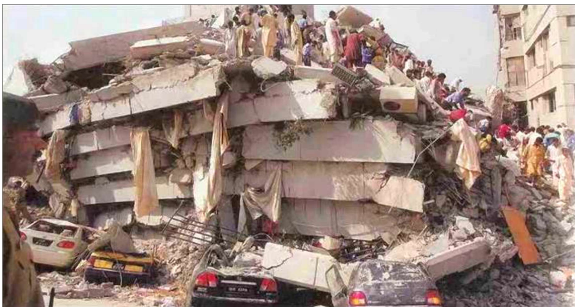
Figura 6 - Colapso de um edifício de dez andares em Islamabad, 2005.
