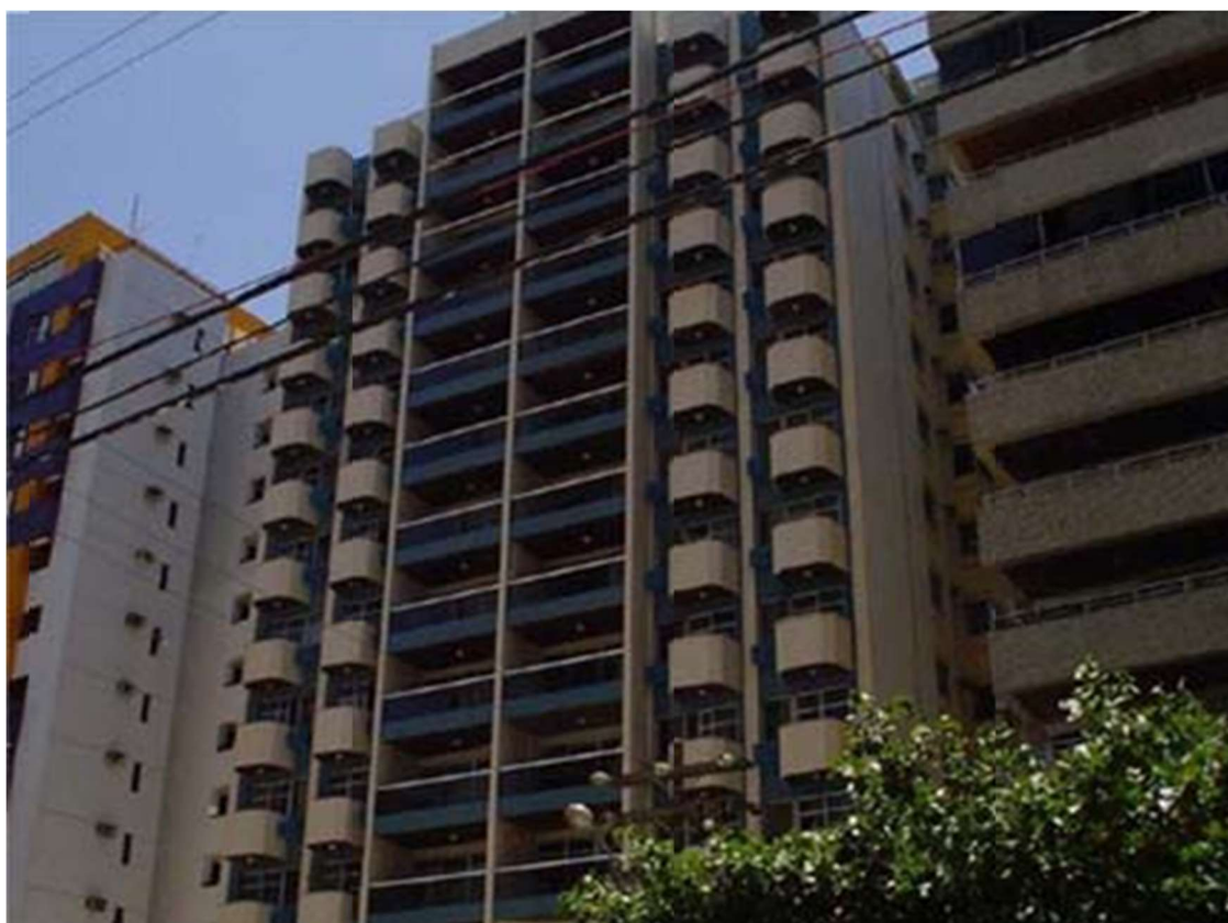
Figura 13 – Edifício Areia Branca antes do colapso
