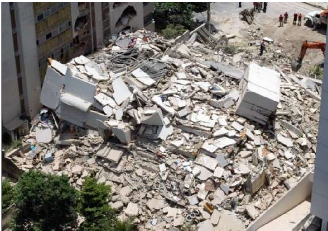
Figura 14 – Edifício Areia Branca depois do colapso
