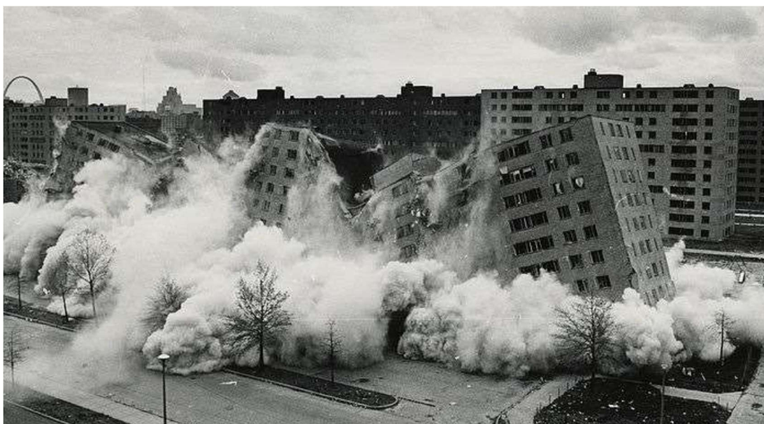
Figura 8 - Demolição de Pruitt – Igoe.
