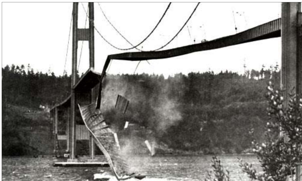
Figura 7 - Colapso da Ponte Tacoma Narrows.
