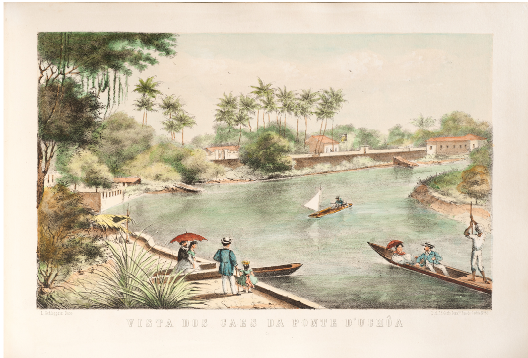
Figura 1 - Vista do Cais da Ponte D’Uchoa
