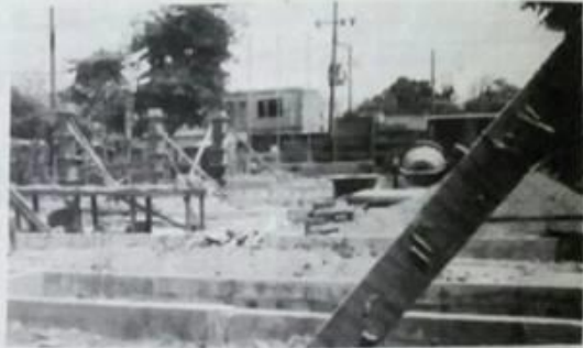
Construção: área de 300 m 2
