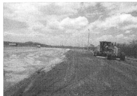
Preparação da Sub-base: Lançamento e espalhamento do agregado AGA (BSSF)
