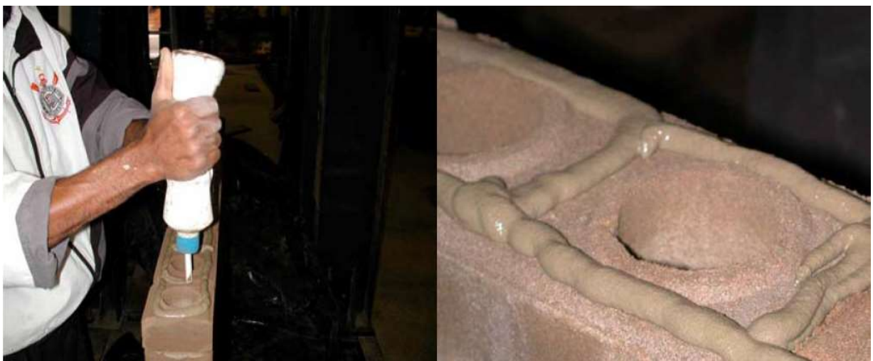
Figura 11 - Exemplo de aplicação de argamassa de assentamento em tijolos de solo-cimento.
