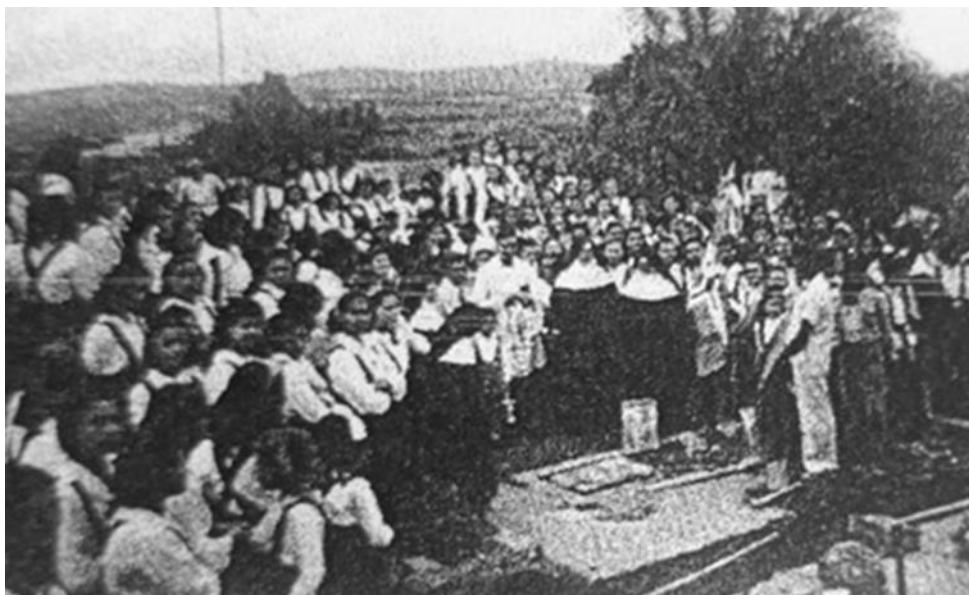
Início da Construção do Ginásio do Colégio Sagrado Coração (1940)
