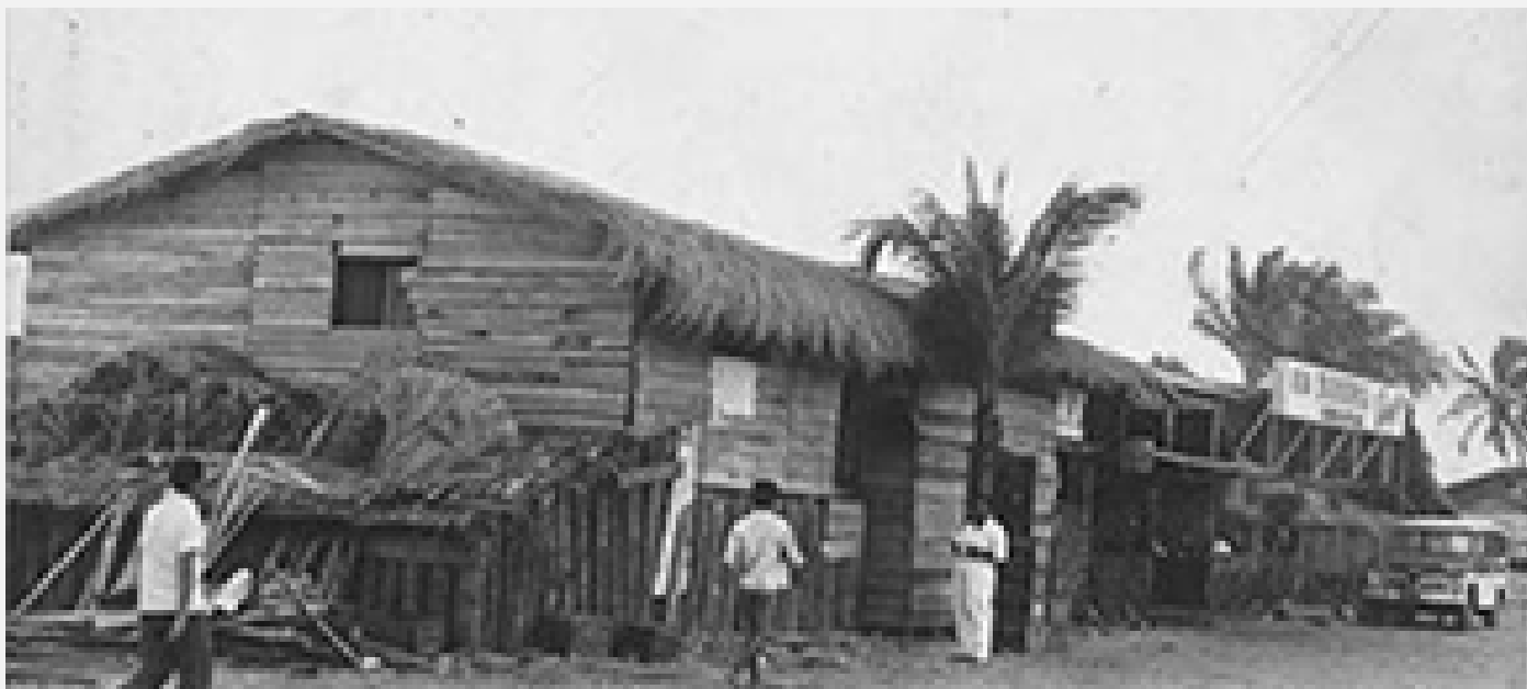
Fotografia 18: Restaurante Rainha do Mar, antes da reforma.
