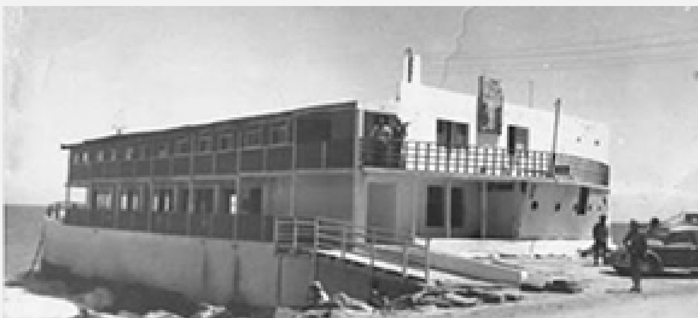
Fotografia 19: Restaurante Rainha do Mar, após a reforma.
