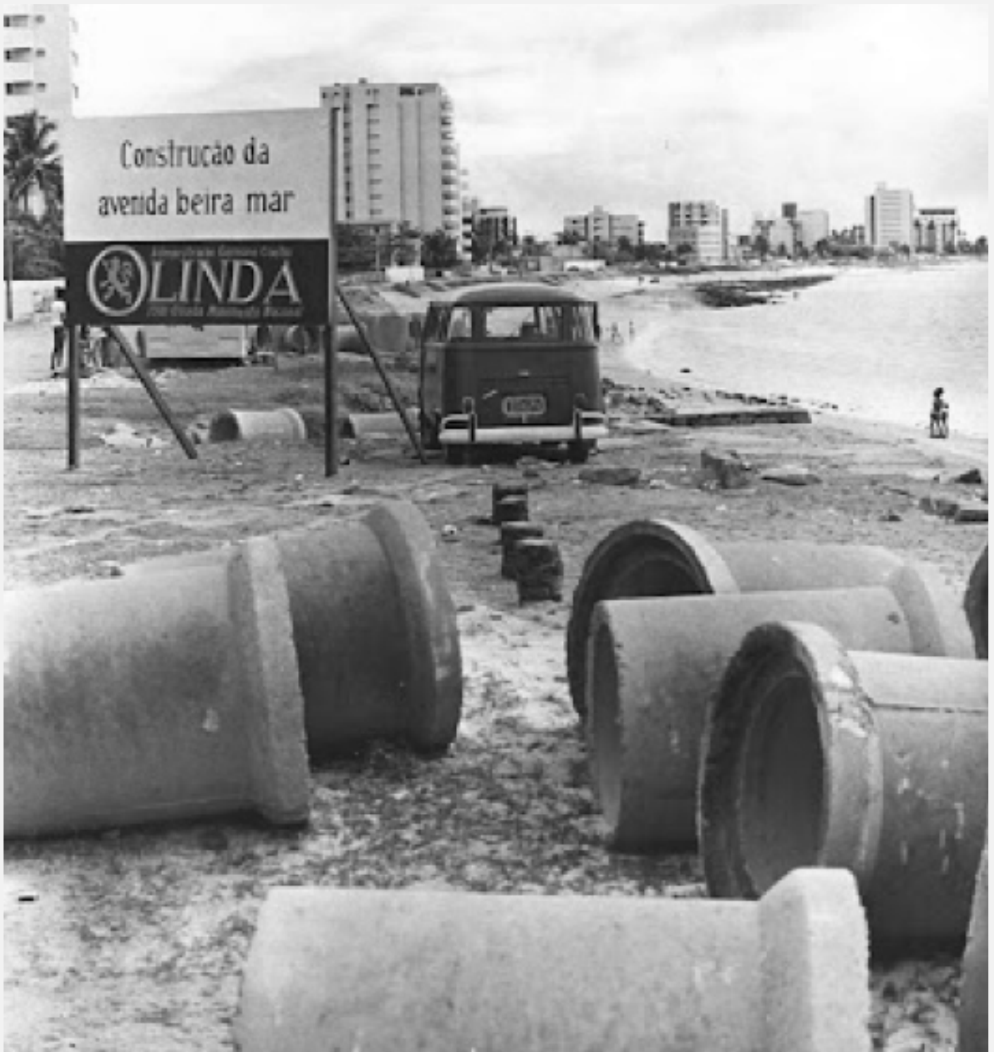
Fotografia 5: Obras de calçamento da Avenida Beira-mar.
