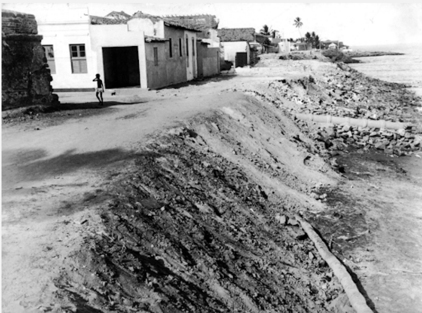
Fotografia 4: Avenida Beira-mar, antes da pavimentação.
