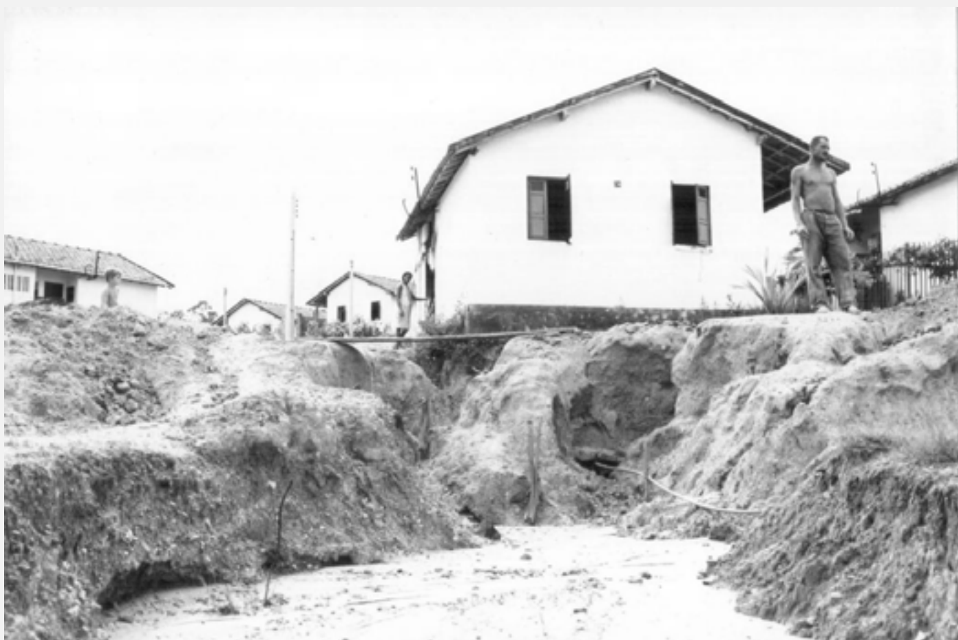
Fotografia 2: Moradores dos primeiros conjuntos habitacionais em Olinda.
