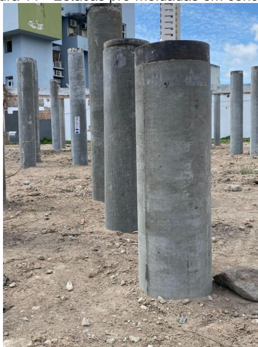
Figura 11 - Estacas pré-moldadas em concreto.
