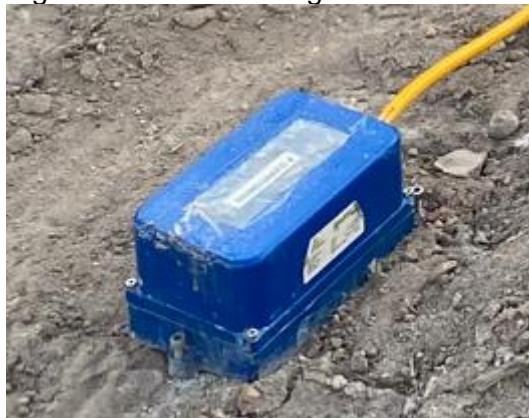
Figura 18 – Sensor de geofone em obra.
