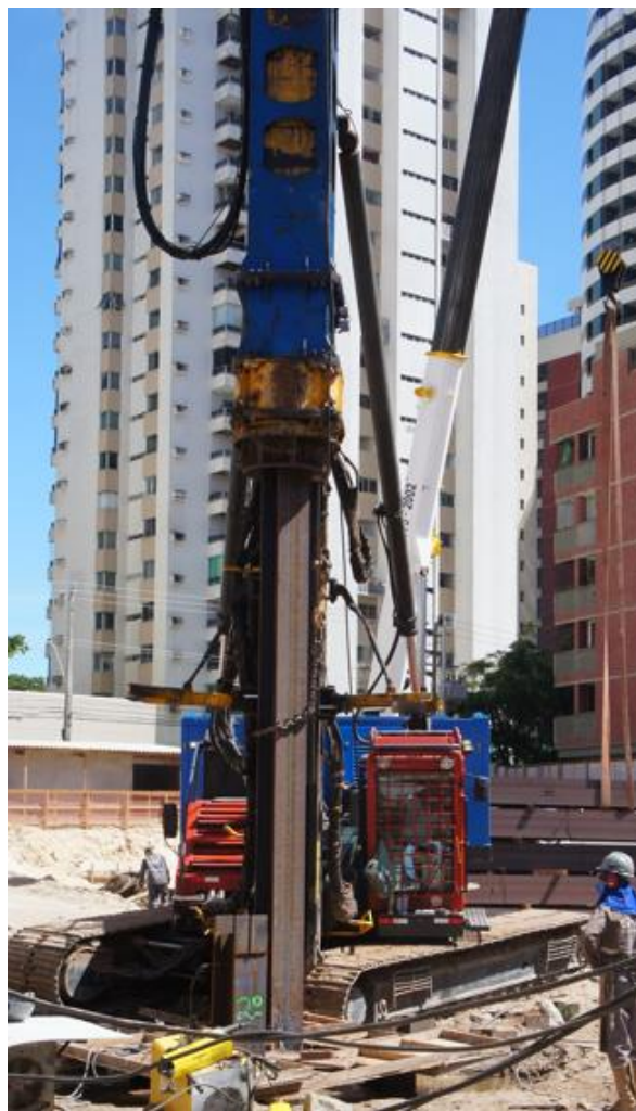
Figura 13 – Cravação à Percussão
