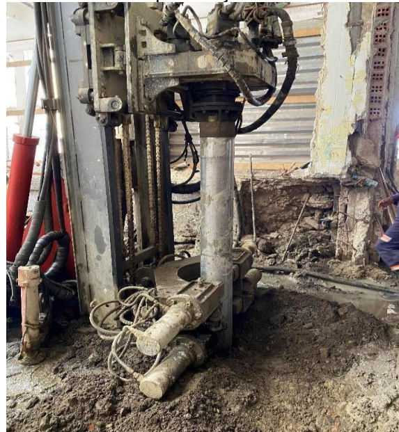
Figura 15 – Processo de perfuração do solo de forma rotativa
