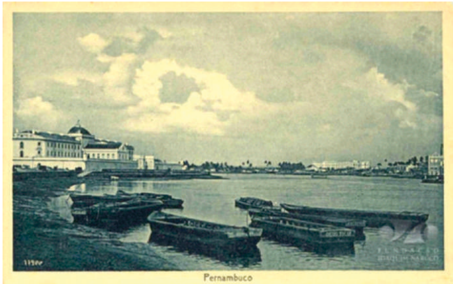
Imagem 37: Casa de Detenção
