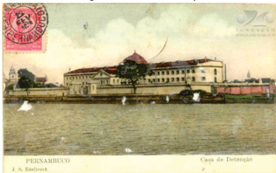
Imagem 31: Casa de Detenção
