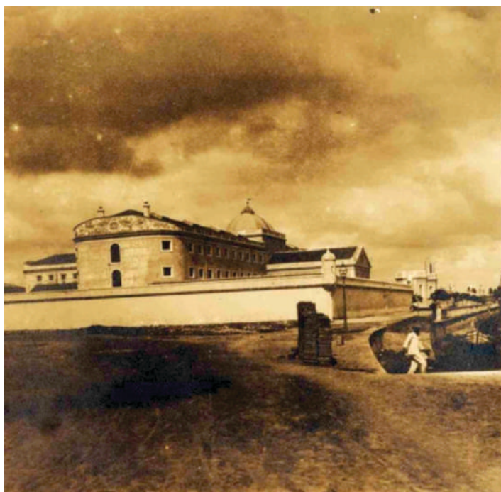
Imagem 34: Casa de Detenção
