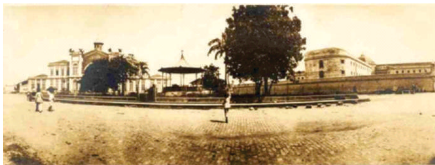
Imagem 30: Casa de Detenção
