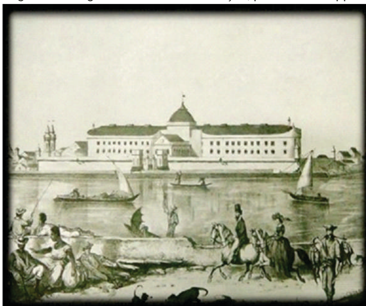
Figura 2: Fotografia da Casa de Detenção, por Luís Schlappriz
