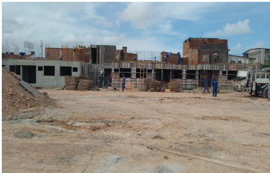
Figura 03: Canteiro de Obra em Construção
