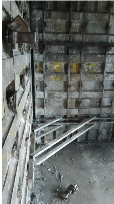
Figura 24- Travamento horizontal de fôrma
