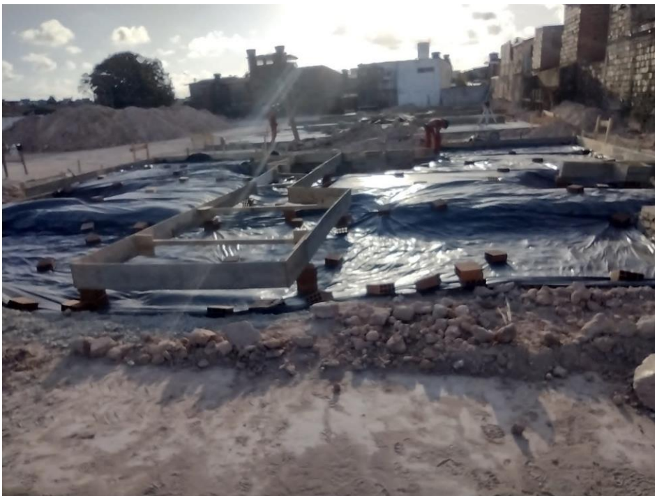
Figura 11- Fundação em radier
