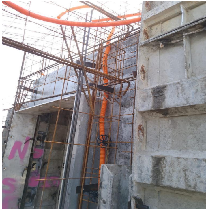
Figura 09: Passagem das tubulações elétricas a espera da concretagem das paredes
