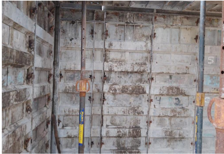
Figura 06: Fôrma metálica com escoramento
