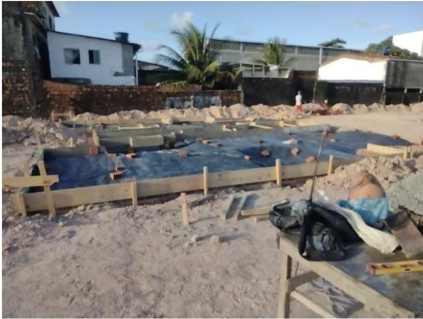
Figura 10-Gabarito de marcação para a fundação em radier
