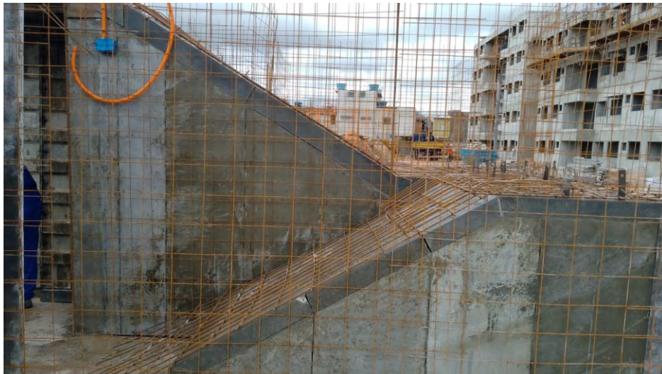
Figura16:Montagem de armações e tubulações
