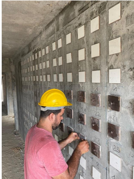
Figura 50: Momento da aplicação das pastilhas metálicas
