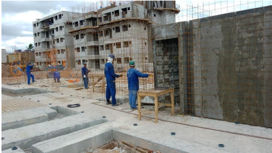
Figura 15- Montagem das tubulações
