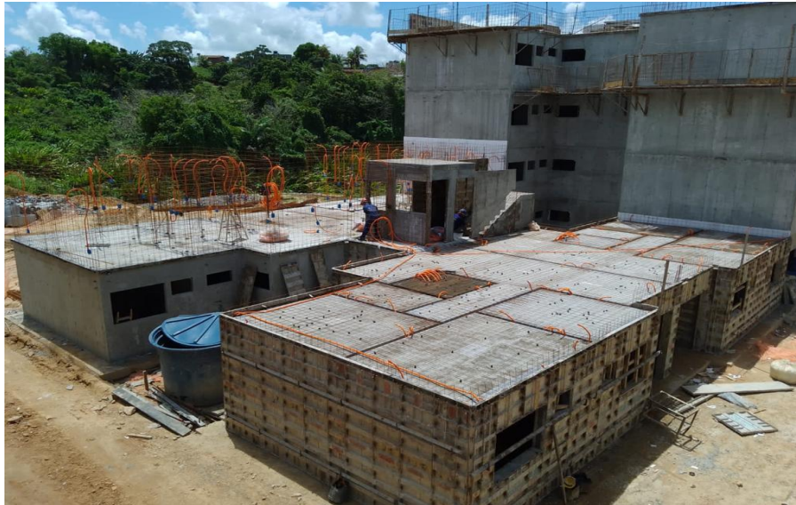
Figura 02: Estrutura de Paredes de Concreto Moldada in Loco
