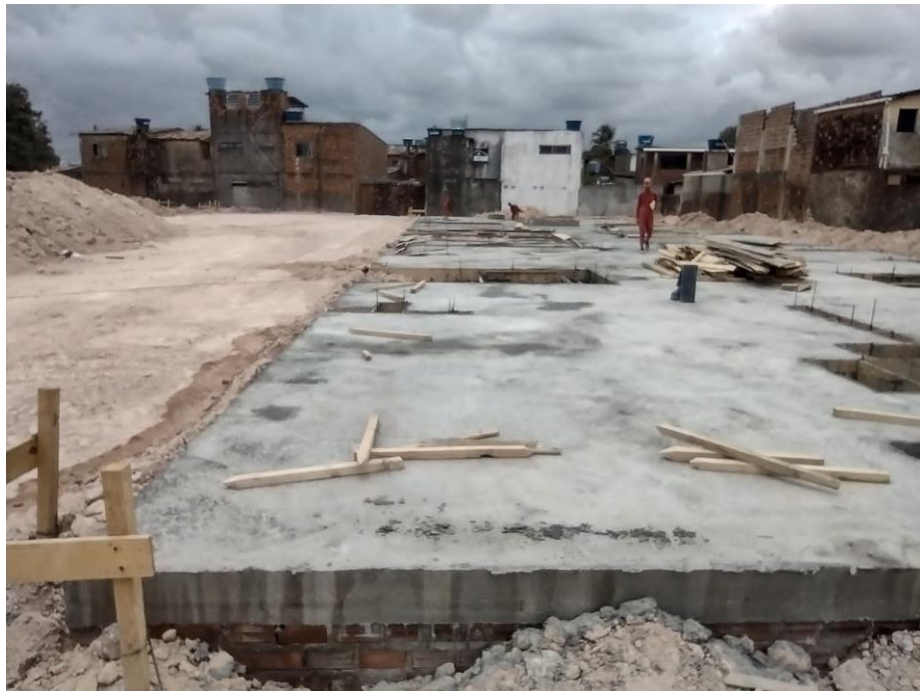
Figura 13: Fundação tipo radier
