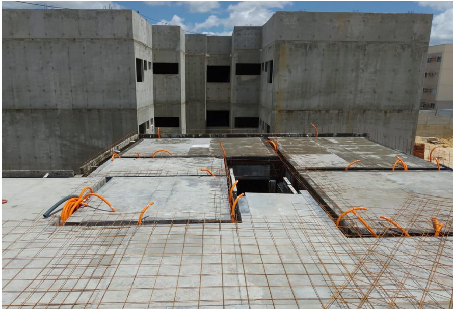
Figura 04: Laje Concretada a espera das instalações elétricas
