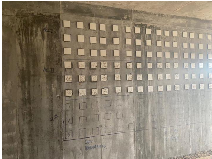
Figura 40: Placas cerâmicas assentadas com argamassa tipo AC II
