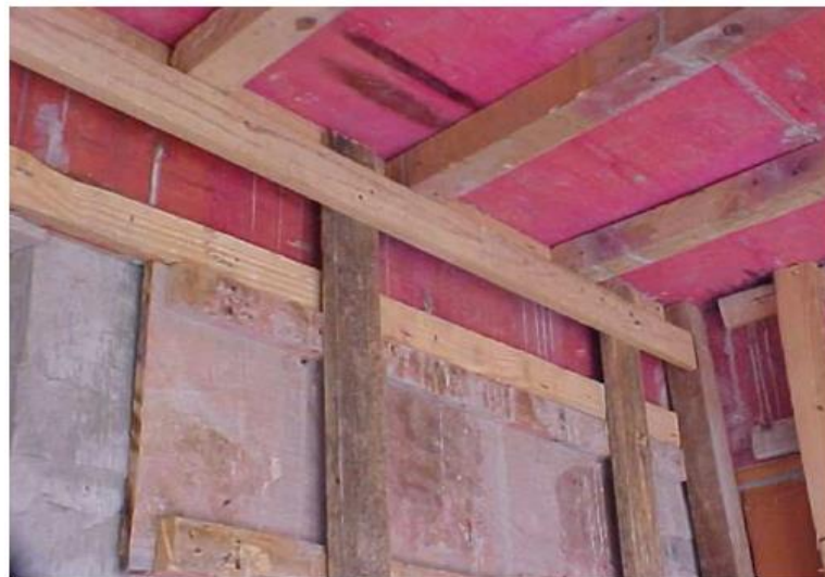
Figura 19: Tipo de fôrma de madeira serrada
