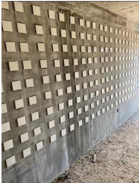
Figura 41: Placas cerâmicas assentadas na parede de concreto moldada in loco
