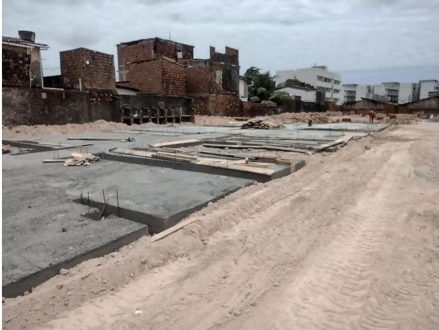
Figura 12-Fundação tipo radier
