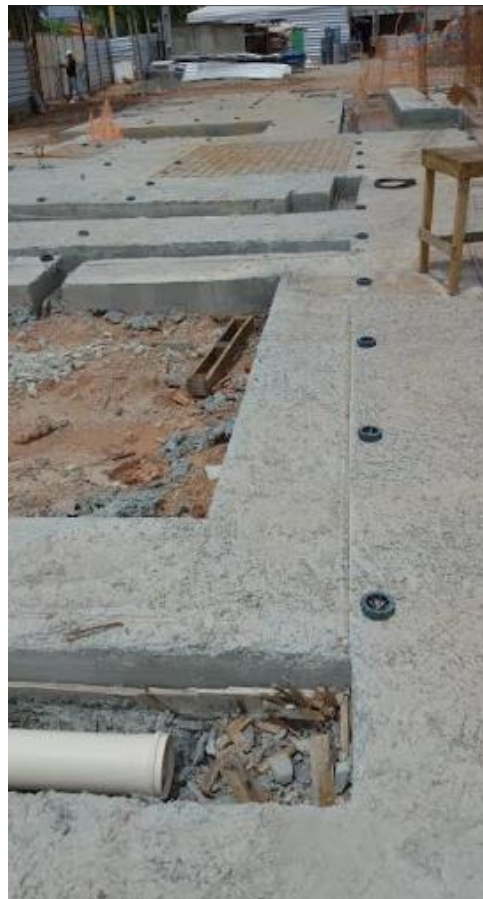
Figura 14-Espaçadores fixados na fundação radier
