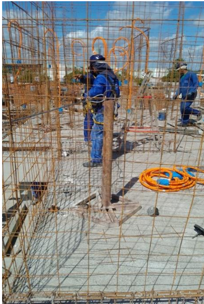
Figura 08: Montagem das tubulações
