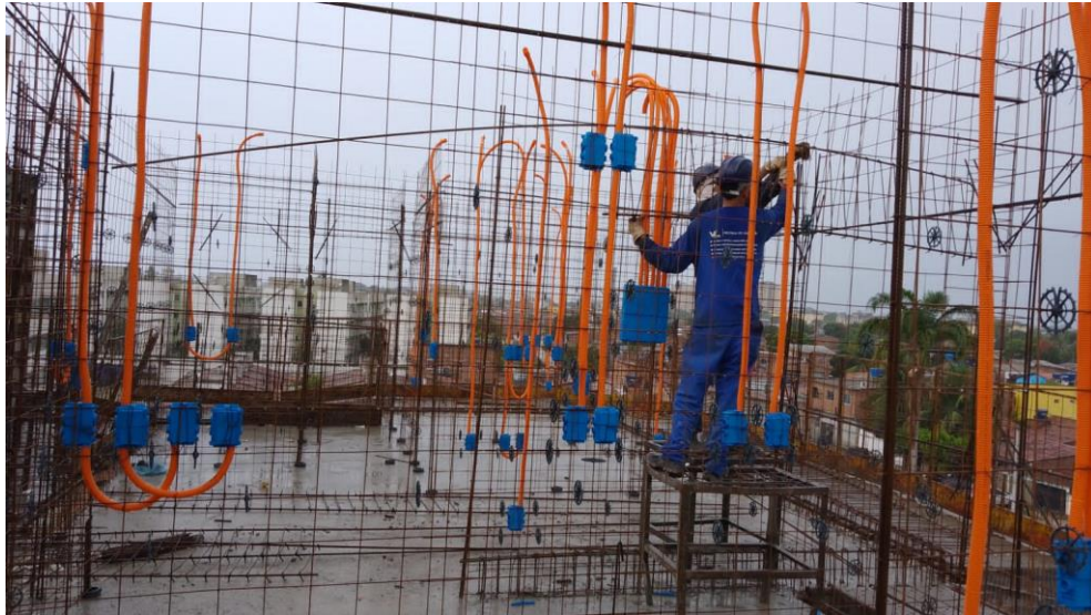
Figura 17: Fixação das tubulações
