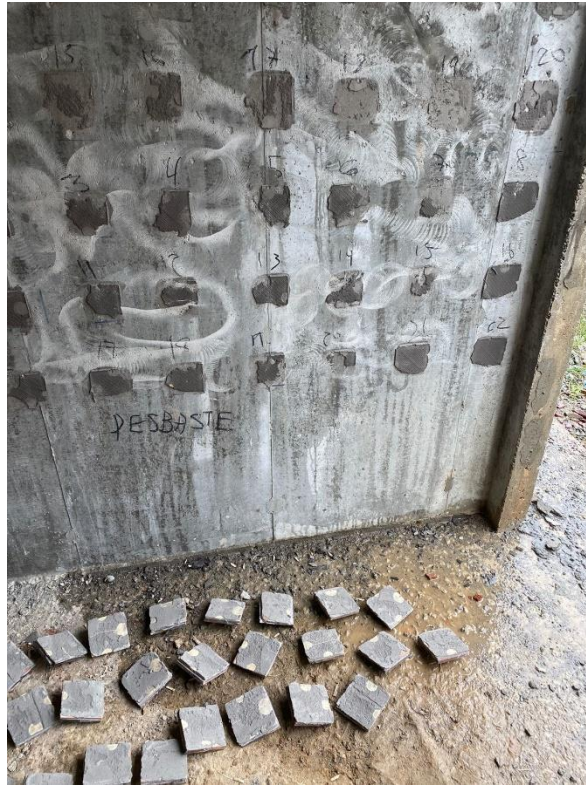
Figura 53: Cerâmicas arrancadas após aferição com o dinamômetro
