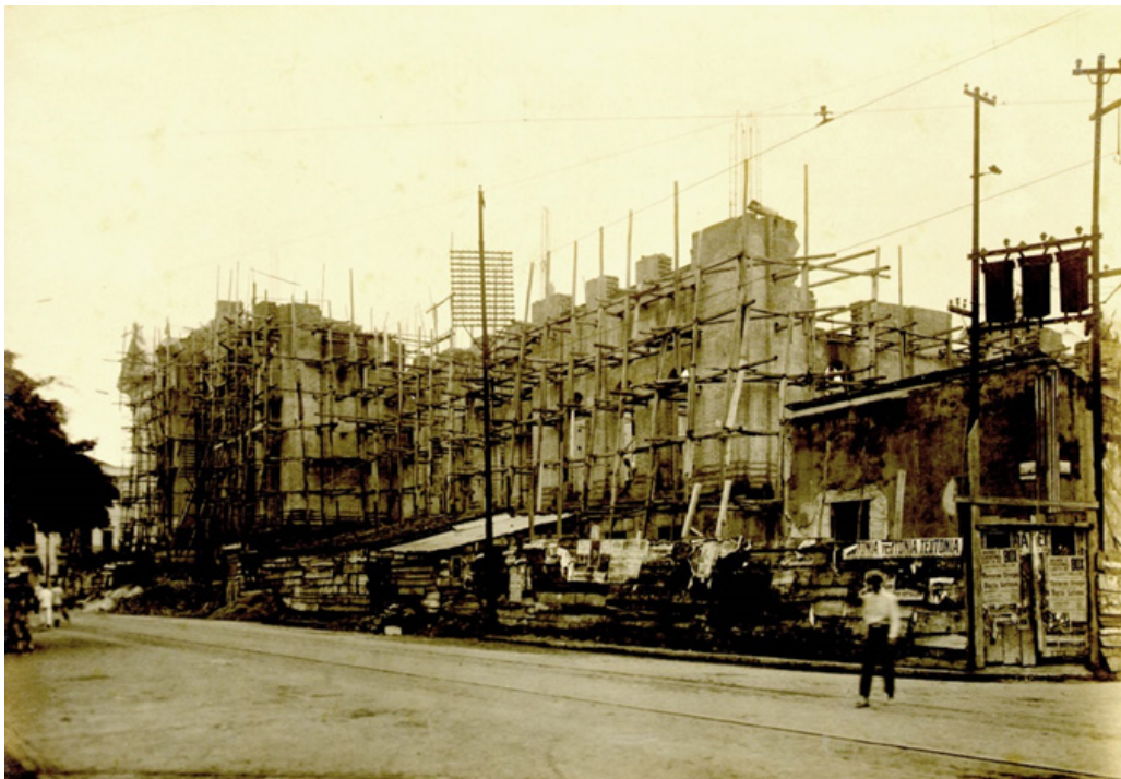
Figura 71 – Ambiente externo do canteiro de obras. Fachada com detalhes da arquitetura clássica: arquitrave, friso e cornija (entablamento), frontão e colunas greco-romanas
