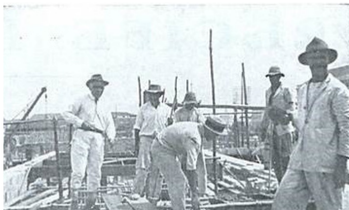
Figura 75 – Mais detalhes dos trabalhos de concretização do piso do segundo pavimento
