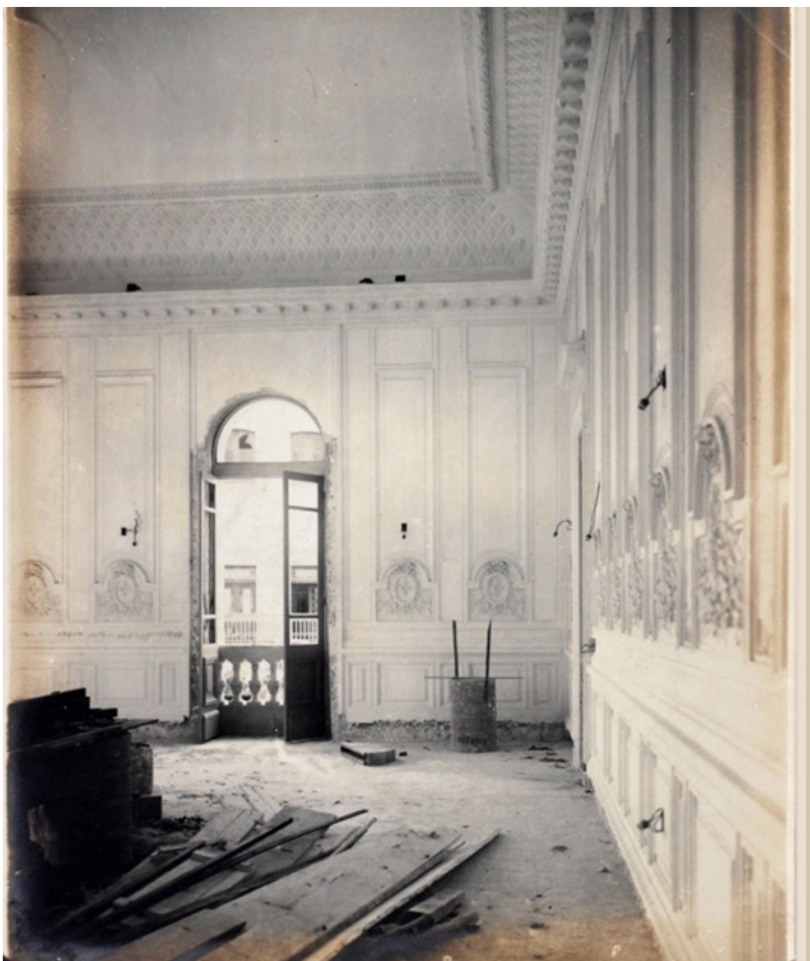
Figura 73 – Canteiro de obras, ambiente interno. Execução dos detalhes ornamentais em gesso e estuque da antiga decoração da Sala dos Desembargadores (atual Sala da Galeria dos Presidentes)
