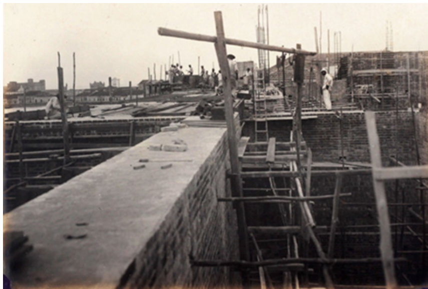
Figura 79 – Detalhe da espessura de uma das paredes, com pouco mais de um metro, feitas em alvenaria de tijolo manual e amarradas por colunas em concreto armado
