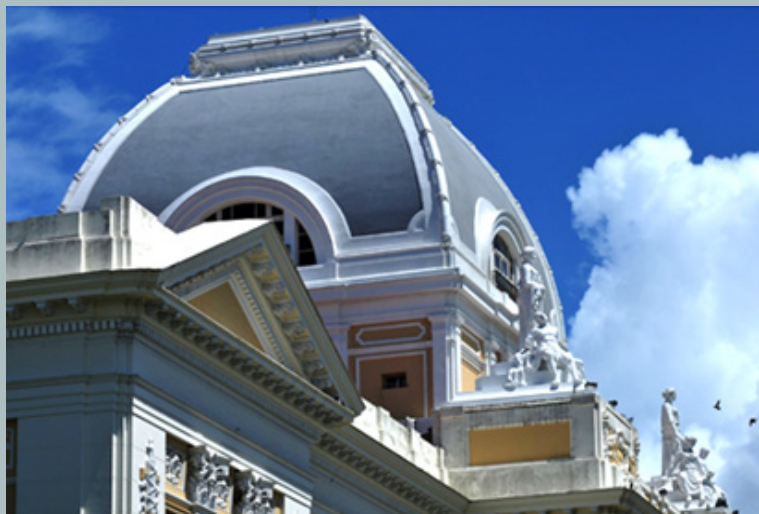
Figura 87 – Detalhe lateral da cúpula
