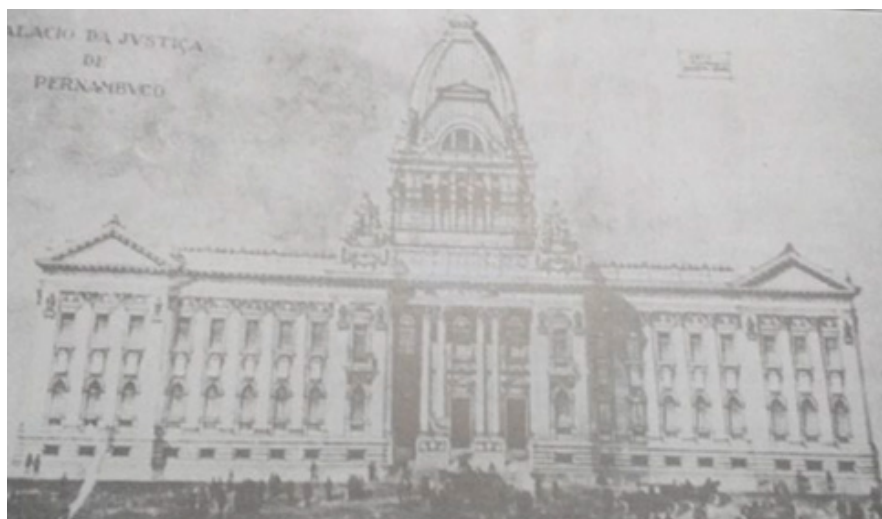
Figura 37 – Sobreposição da cúpula original de formato octogonal modificada para o formato quadrado
