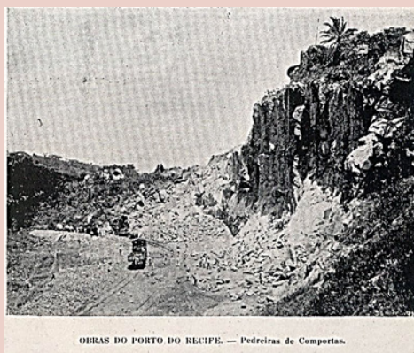
Figura 61 – Pedreira de Comportas
