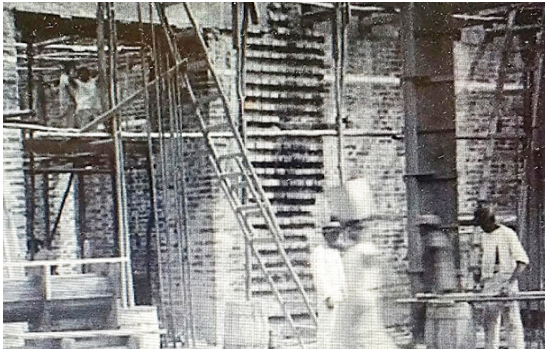
Figura 78 – Ampliação de detalhe da foto anterior, com operários nos andaimes, no canto superior esquerdo, e serviços de carpintaria e transporte de materiais em lata sobre a cabeça, no canto inferior direito
