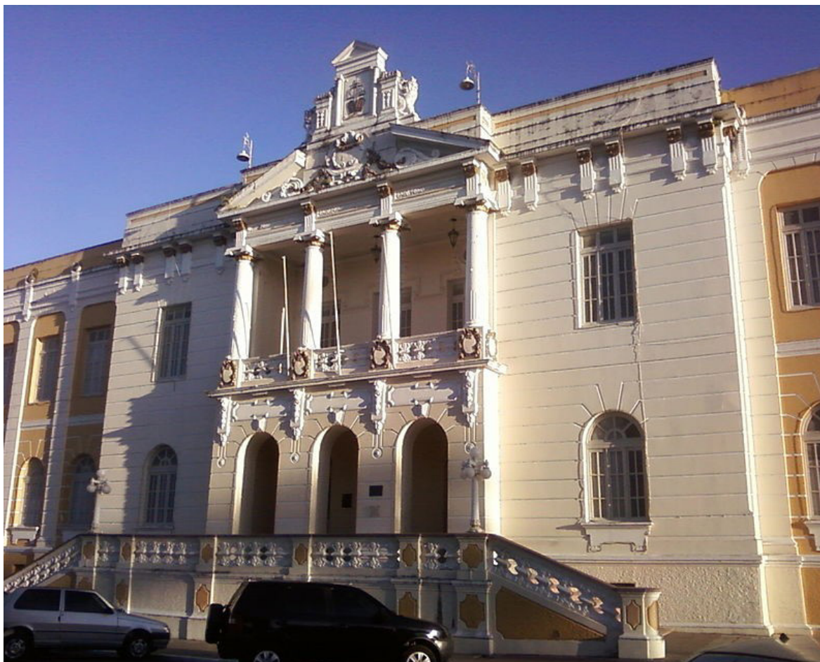
Figura 147 – Detalhe da entrada do prédio do TJPB
