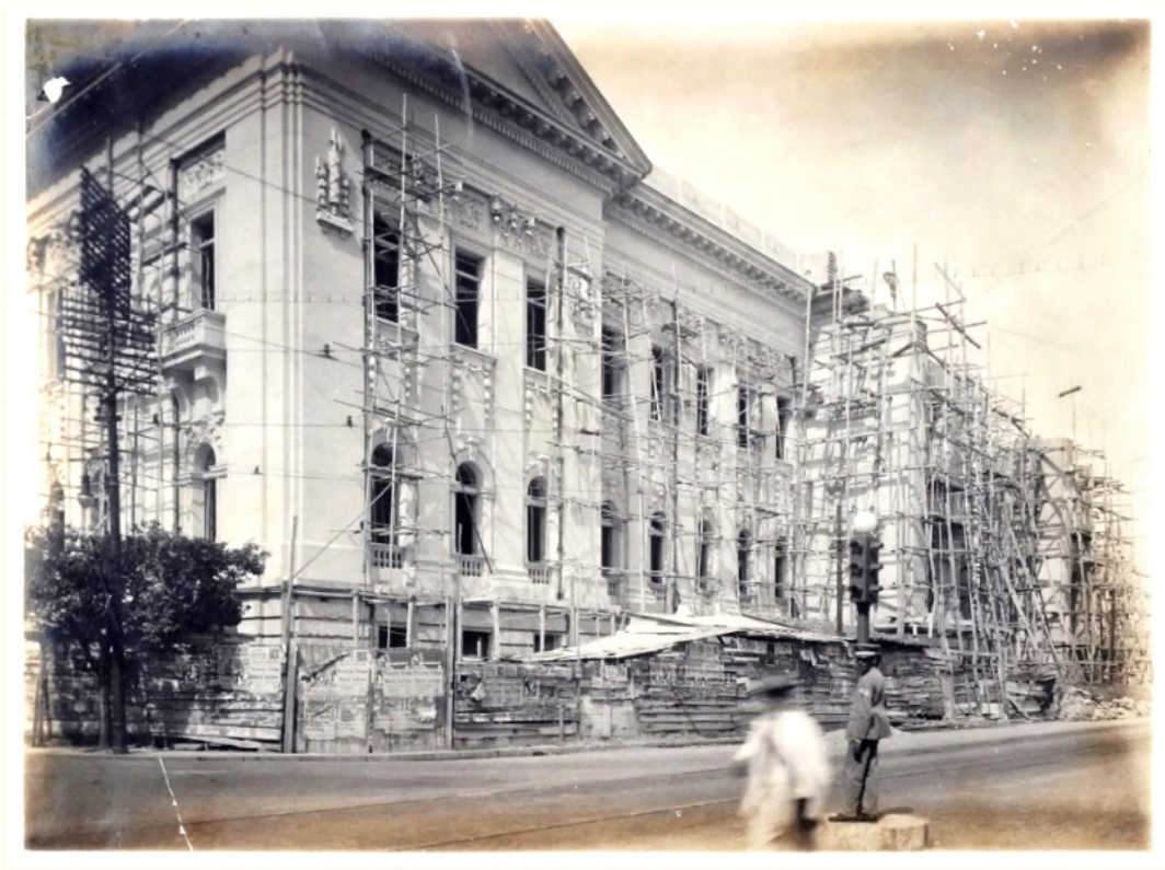
Figura 82 – Ambiente externo do canteiro de obras. Fachada principal ainda sem a cúpula. Detalhe da confecção dos ornamentos em estuque
