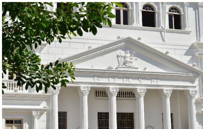
Figura 144 – Detalhe da fachada do TJMA
