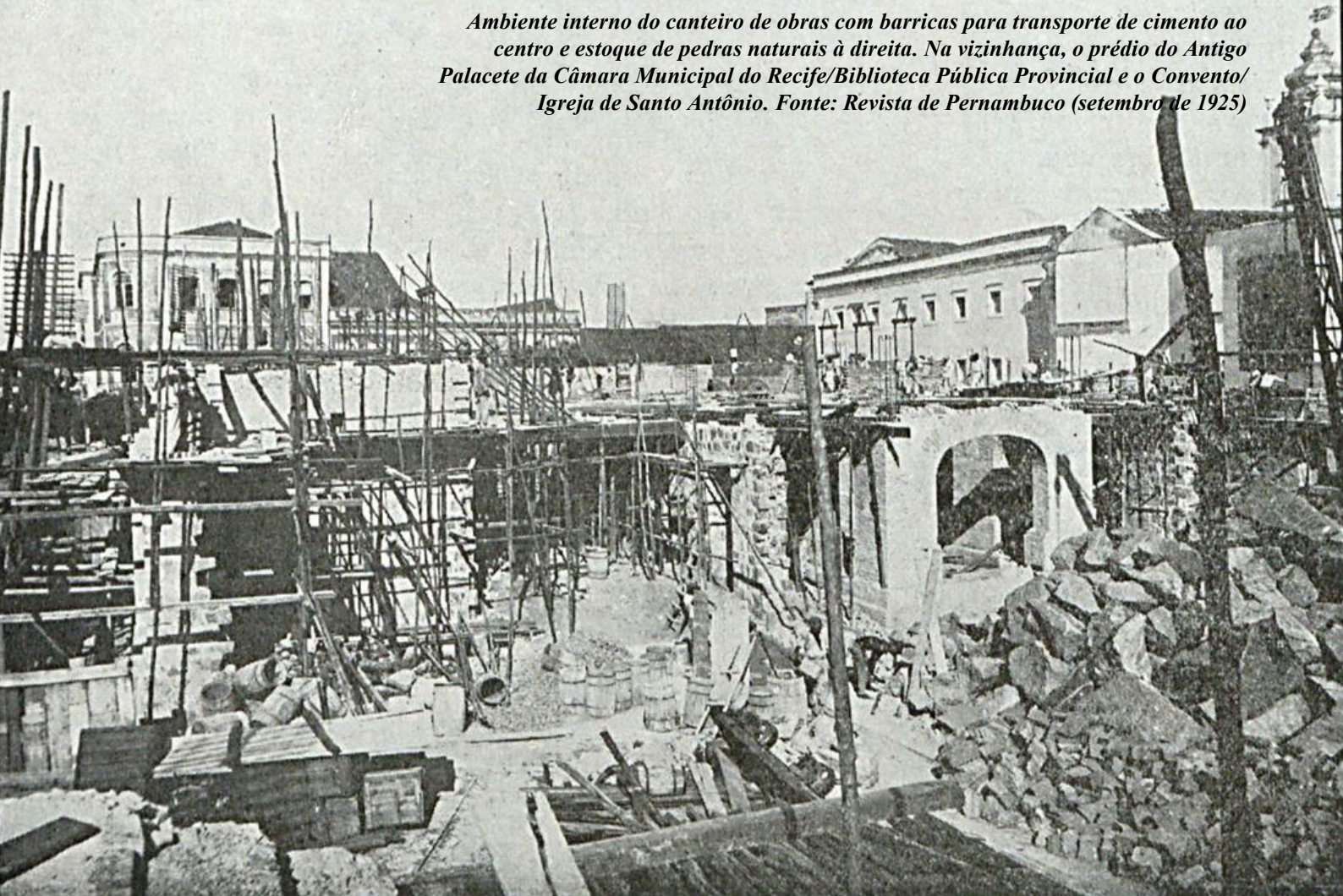
Ambiente interno do canteiro de obras com detalhes dos arcos romanos em alvenarias de pedra natural e pessoas sobre andaimas ao centro e no canto superior direito. Fonte: Revista de Pernambuco (setembro de 1925)
