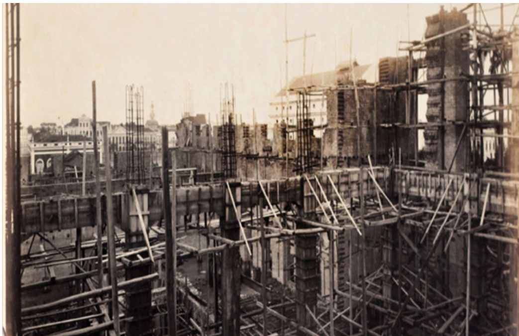
Figura 69 – Ambiente interno do canteiro de obras, com a concretagem dos pilares
