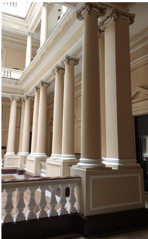
Figura 104 – Detalhes das colunatas do primeiro pavimento
