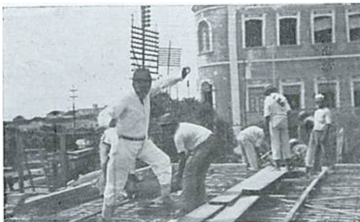
Figura 74 – Trabalhos de concretização do piso do segundo pavimento
