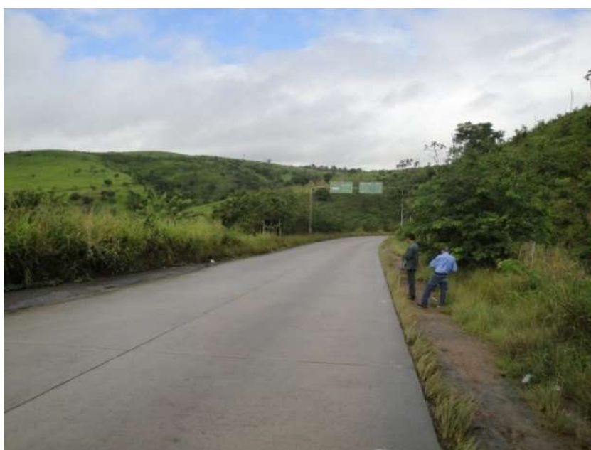
Figura 16 – Rodovia PE-177 em relevo ondulado
