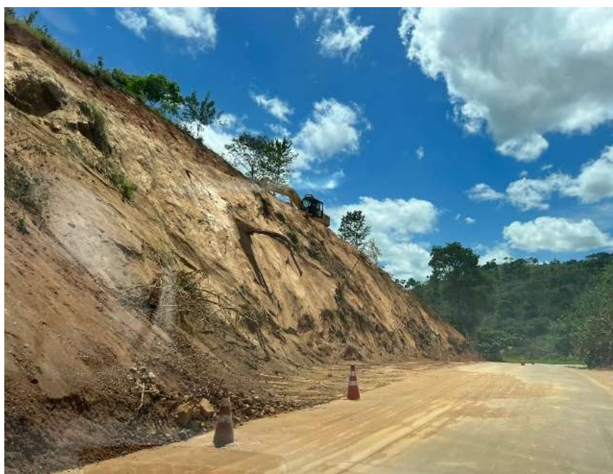
Figura 9h– Rodovia PE-177 (07/2022)
