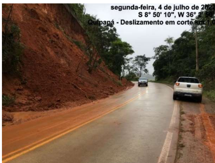
Figura 9d– Rodovia PE-177 (07/2022)
