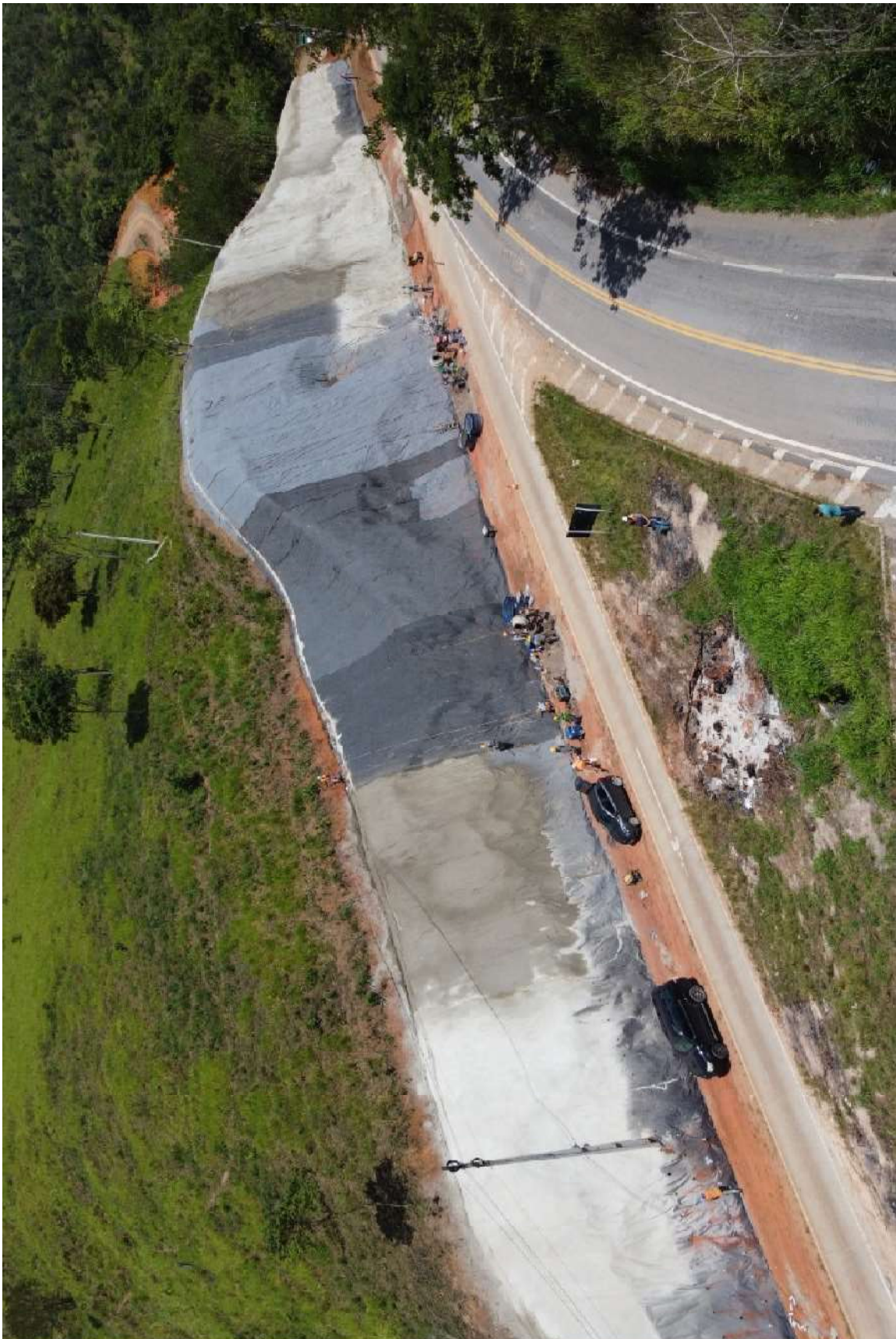
Figura 62c – Dispositivos de drenagem (sarjeta de pé de corte), aplicação de geomanta
