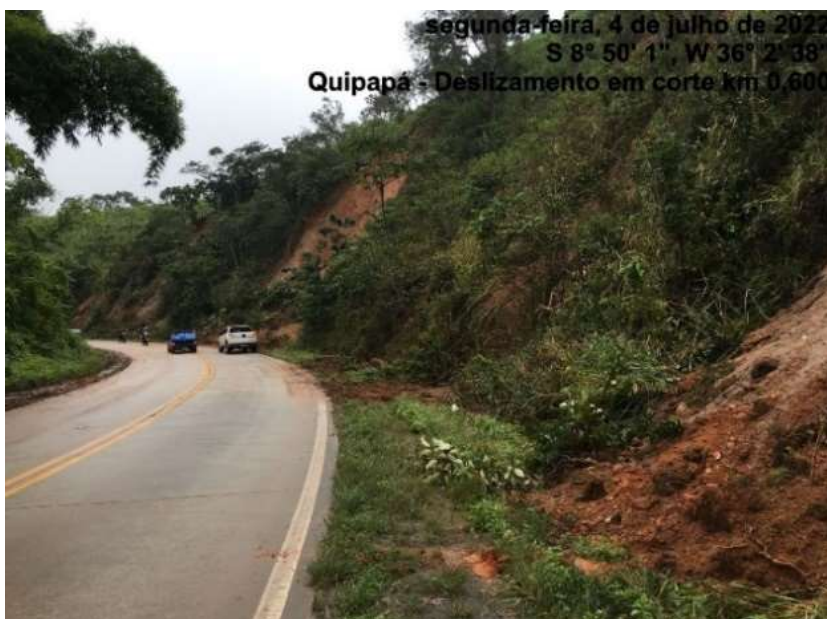
Figura 9b– Rodovia PE-177 (07/2022)
