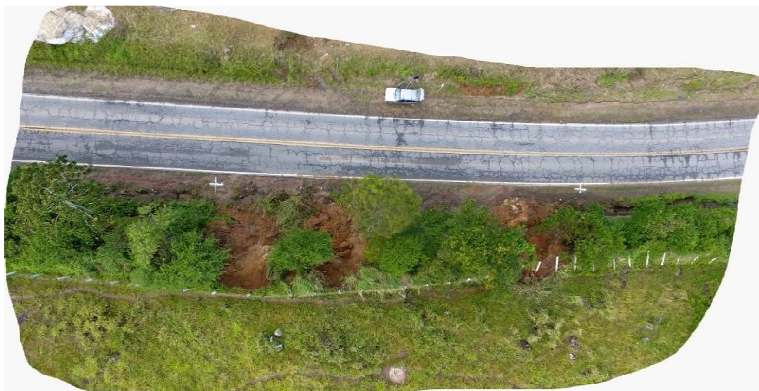
Figura 32j Registro do movimento de massa verificado
