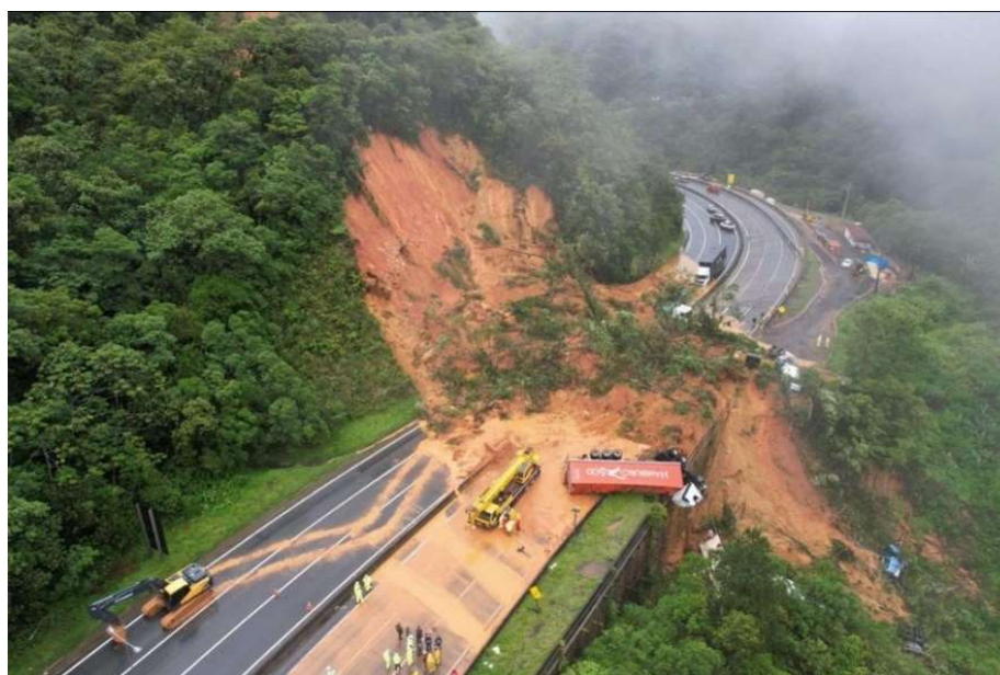
Figura 05– Deslizamento sobre a BR-376/PR (2022)
