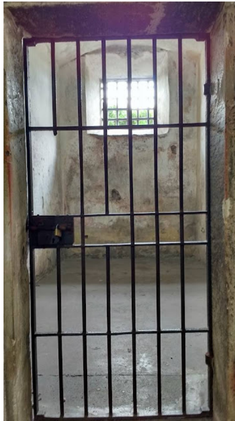
Imagem 21 – Cella da antiga casa de detenção do Recife.
