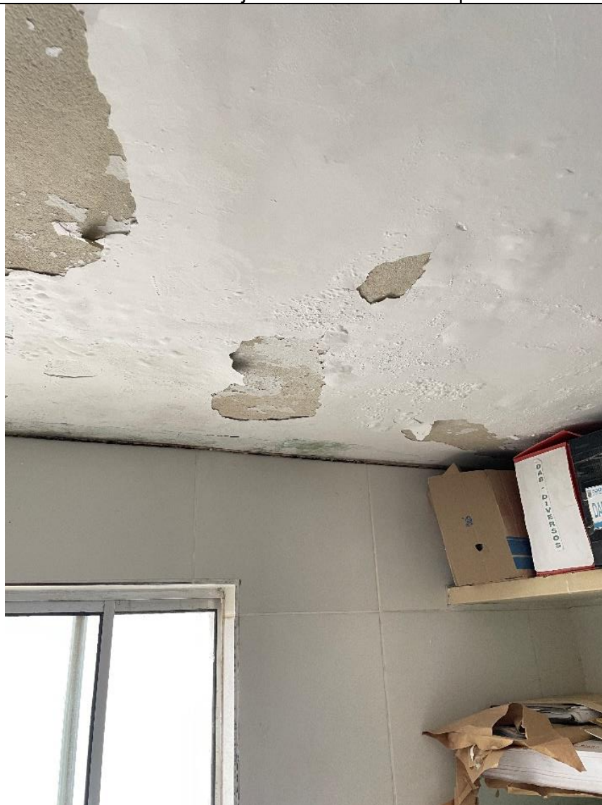
Quadro 19 - Laje do teto na sala de arquivos
