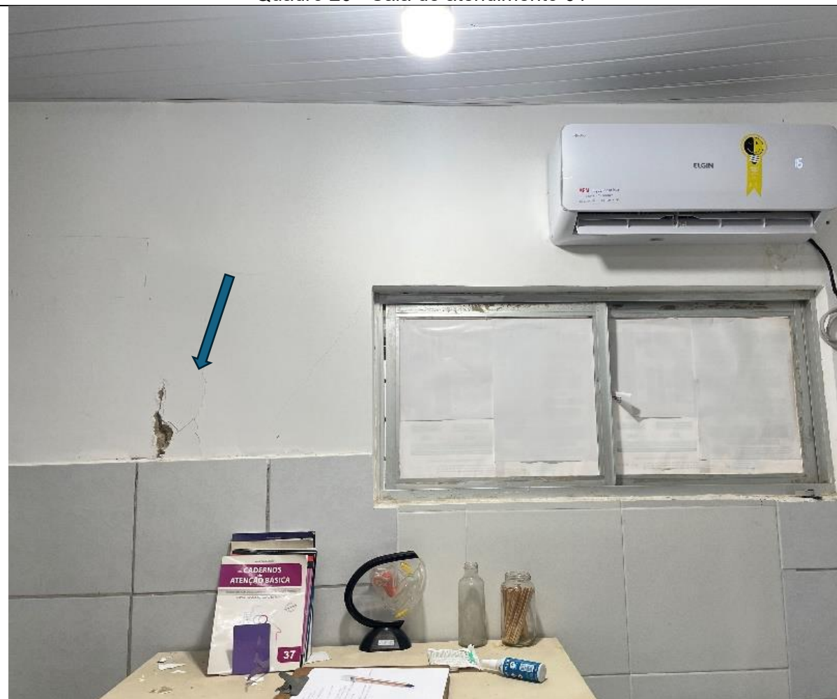
Quadro 20 - Sala de atendimento 01
