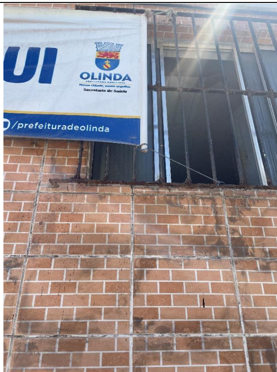
Quadro 52 - Fachada frontal (antes da pintura sobre a cerâmica)
