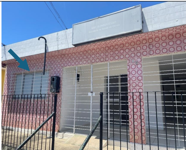
Quadro 87-Fachada Frontal
