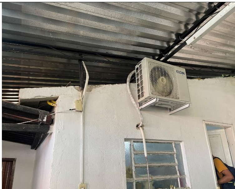
Quadro 71- Parede externa a Copa 2
