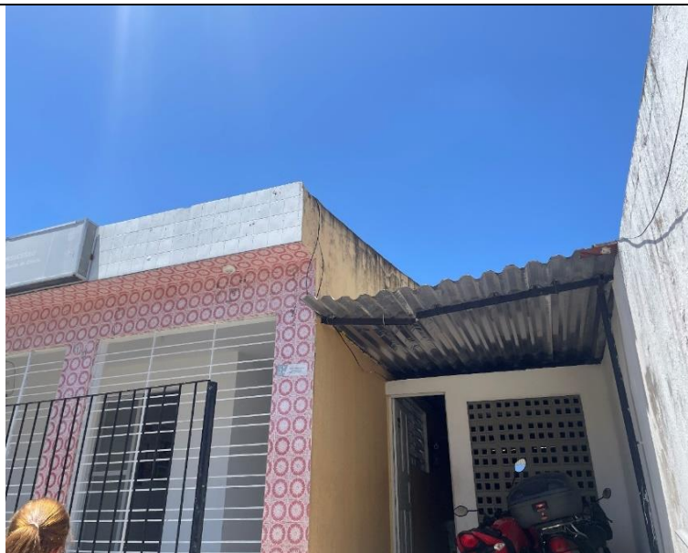
Quadro 67-Fachada frontal
