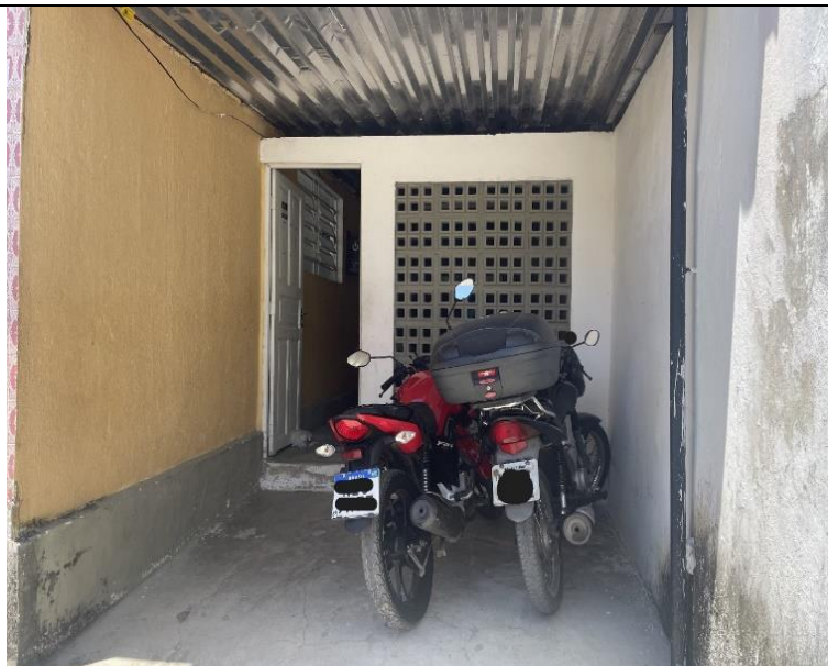
Quadro 66 - Fachada frontal
