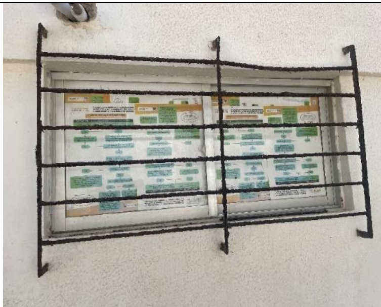
Quadro 54 – Janela Fachada lateral
