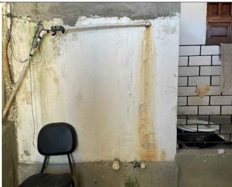
Quadro 74- próximo a casa de bomba
