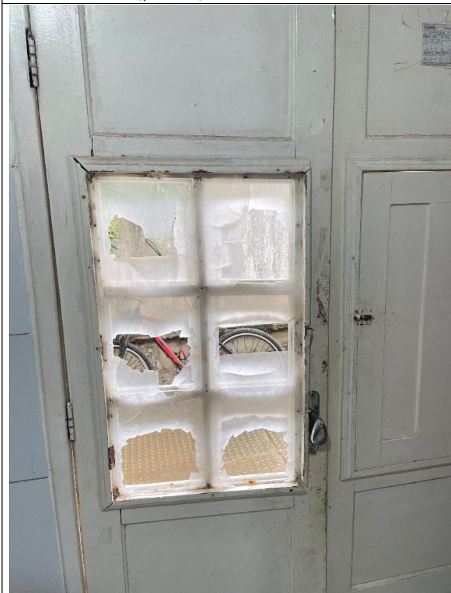
Quadro 28 - Porta de entrada
