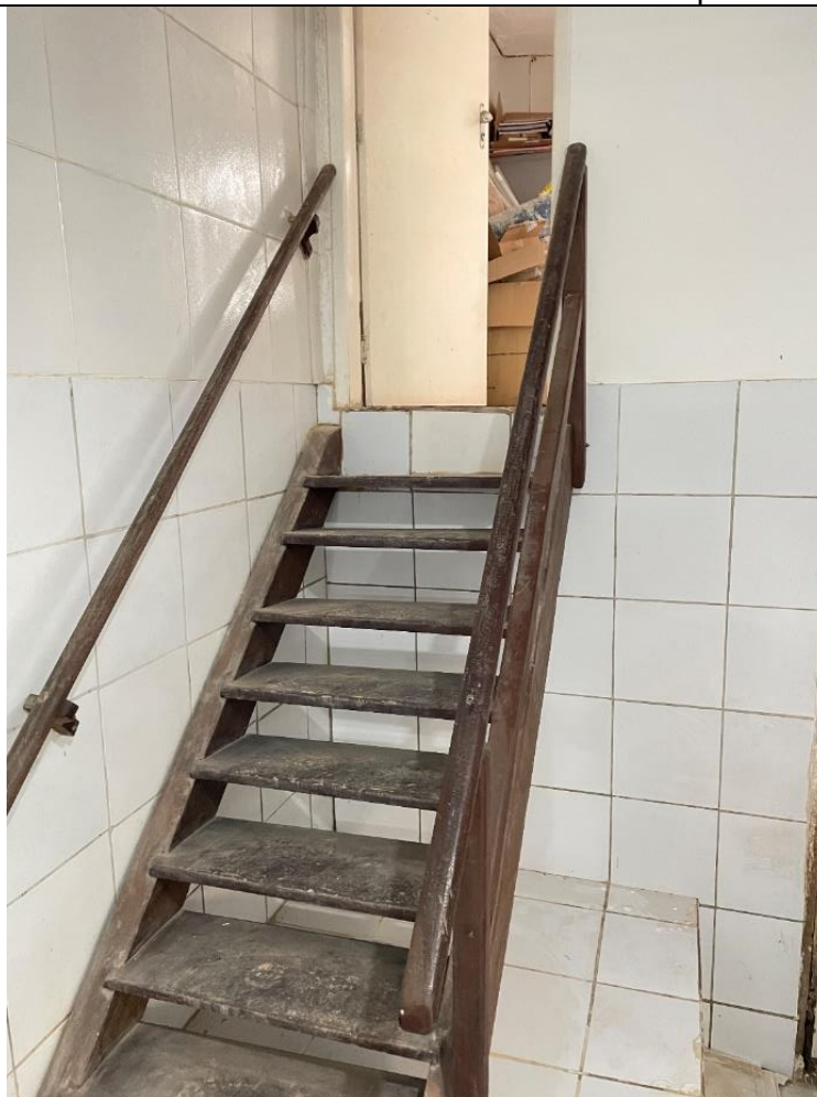
Quadro 32- Escada de acesso à sala do arquivo
