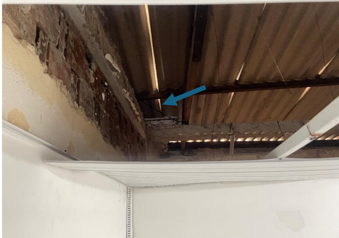
Quadro 17- Viga da cobertura
