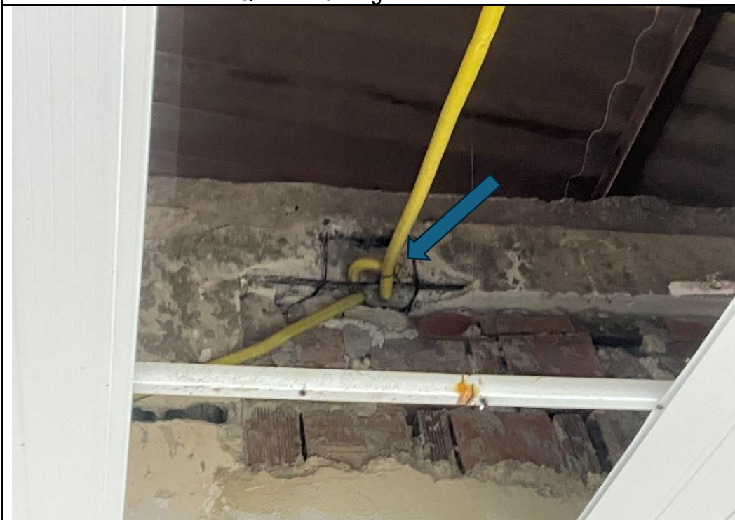
Quadro 18 - Viga da cobertura
