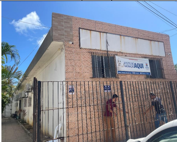
Quadro 51 - Fachada frontal (antes da pintura sobre a cerâmica)
