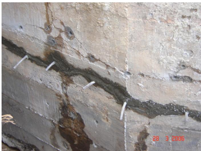
**Figura 5.34 – Fechamento superficial da trinca com espessura maior que 10 mm.**
