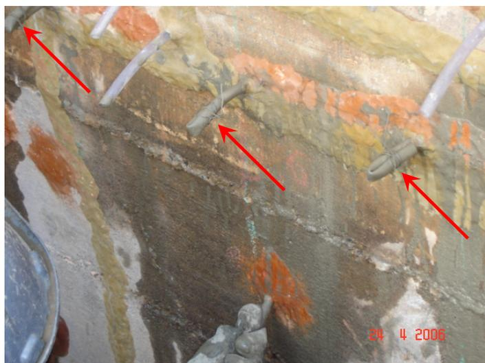
**Figura 5.51 – Fechamento dos purgadores após preenchido com microcimento.**
