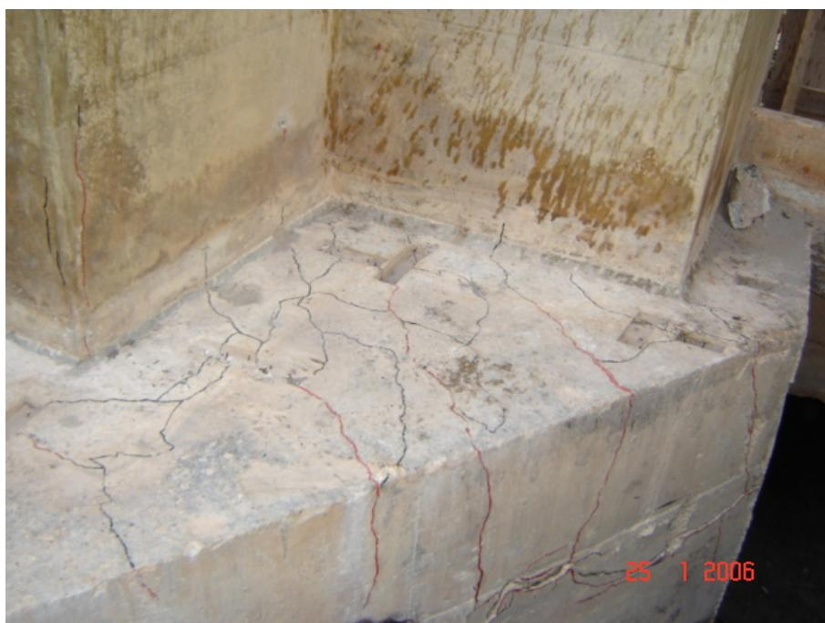
**Figura 4.1 – Bloco de fundação com fissuras em forma de mapa.**
