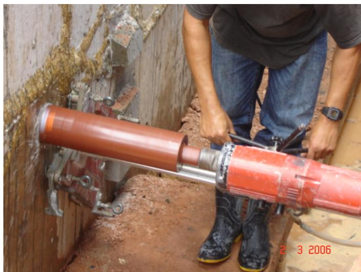
**Figura 5.22 – Retirada de testemunho para análise laboratorial.**
