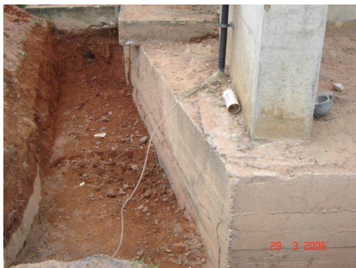
Figura 5.2 – Escavação preliminar para inspeção visual do bloco.
