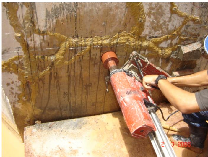
**Figura 5.26 – Retirada de testemunho 150mm abaixo da trinca principal.**
