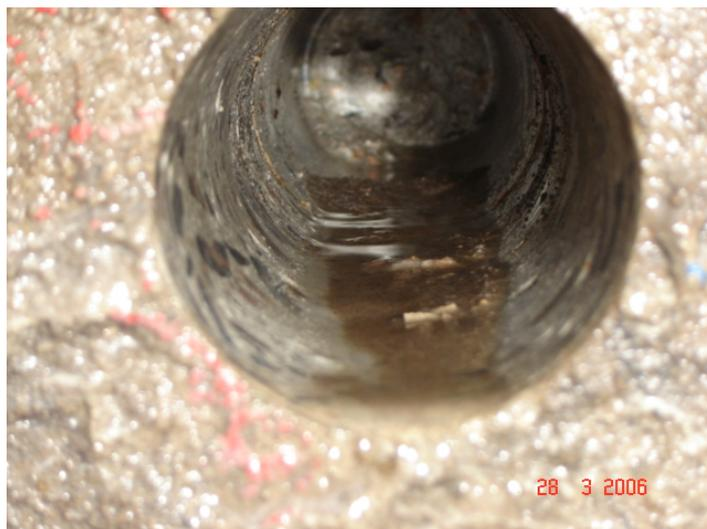
**Figura 5.41 – Areia depositada proveniente do interior das trincas.**
