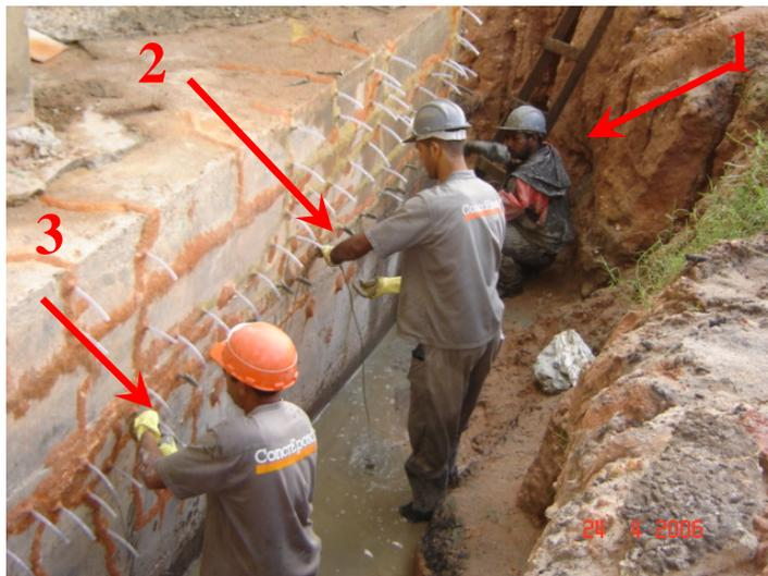
**Figura 5.52 – Pontos de saída do microcimento pelos purgadores.**
