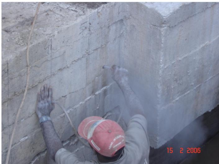
**Figura 5.31 – Retirada de pó nos furos dos purgadores.**
