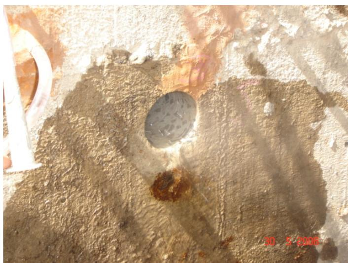
**Figura 5.45 – Saída de água retida nas trincas pela força do ar injetado.**
