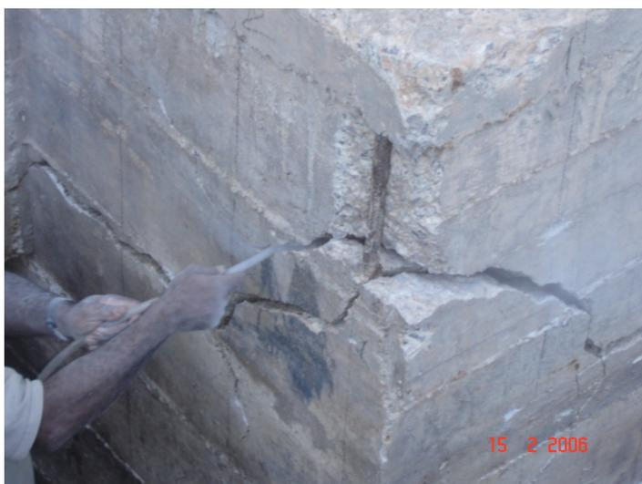
**Figura 5.32 – Retirada de pó nas trincas e fissuras.**
