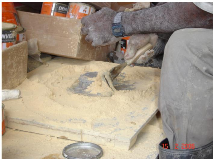
**Figura 5.35 – Preparo da argamassa de epóxi e caulim.**
