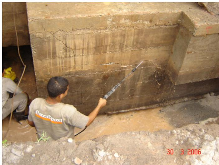
**Figura 5.21 – Lavagem das faces com a lavadora de alta pressão.**
