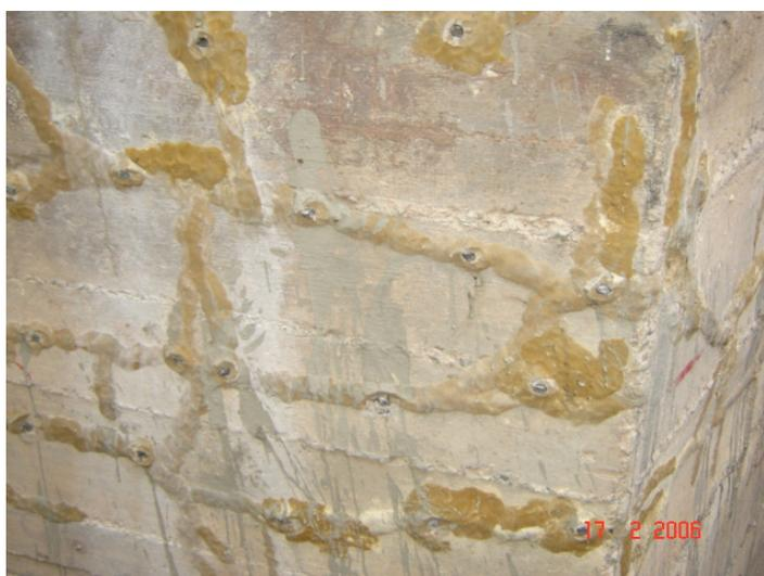
**Figura 5.54 – Corte dos purgadores rente a face do bloco.**
