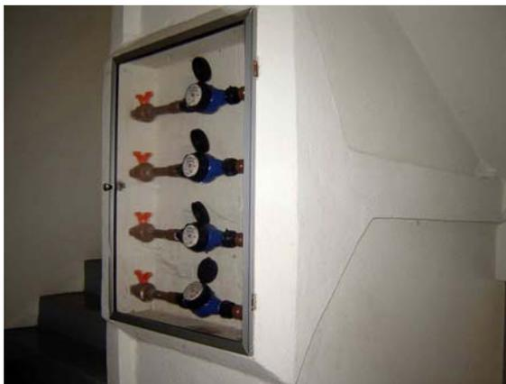
**Figura 4.1.3.3 – Caixa dos hidrômetros do 2º ao 6º pavimento**
