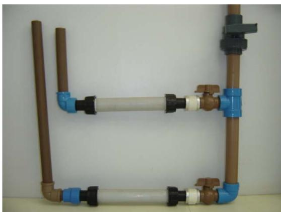
**Figura 2.2.15 – Ligação dos hidrômetros**
