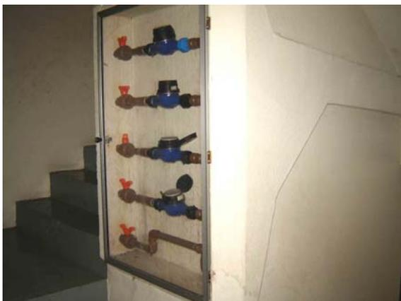
**Figura 4.1.3.6 – Caixa dos hidrômetros do 1º pavimento**
