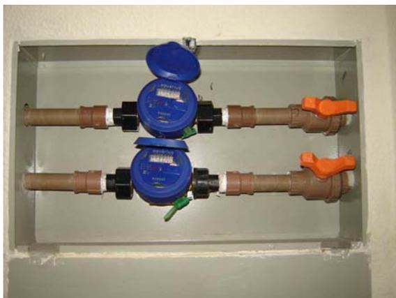
**Figura 4.1.1.3 – Caixa para hidrômetros dos apartamentos pares**
