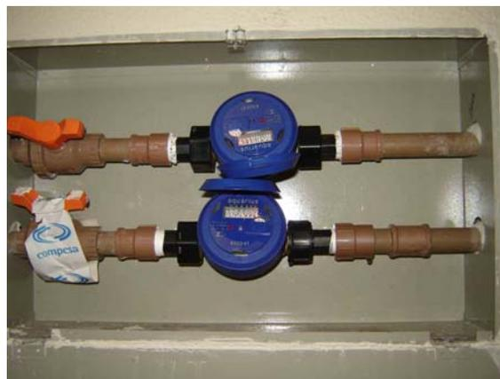
**Figura 4.1.1.4 – Caixa para hidrômetros dos apartamentos ímpares**
