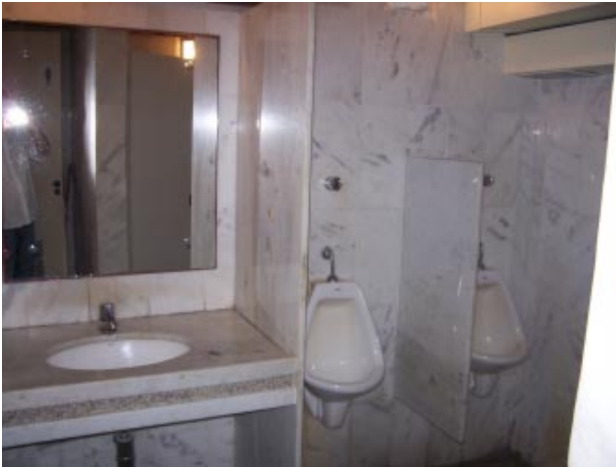
Figura 3.78: interior dos sanitários com diversos materiais modernos. Fonte: João Batista
