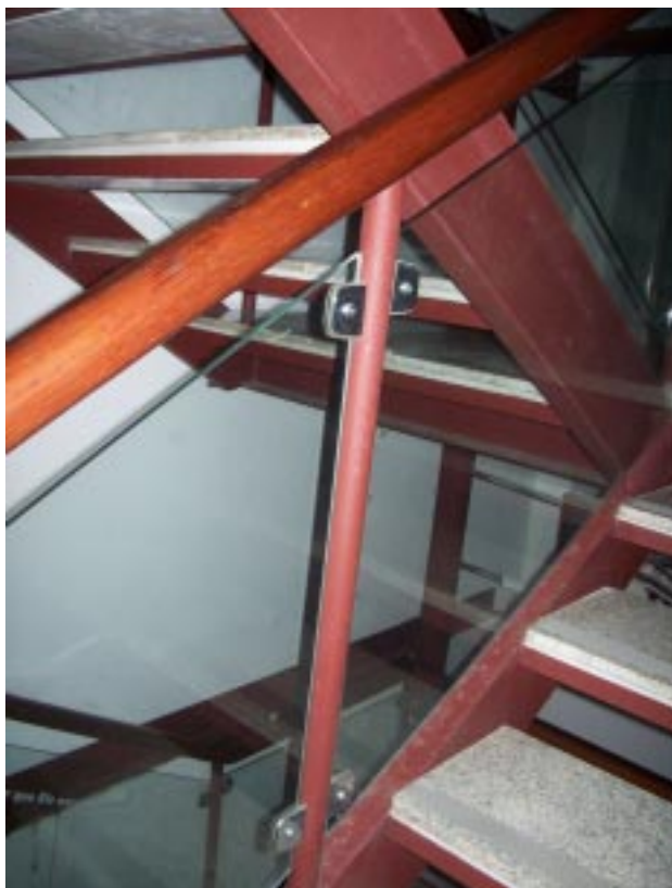
Figura 3.81: Detalhe do guarda-corpo em vidro temperado fume.
