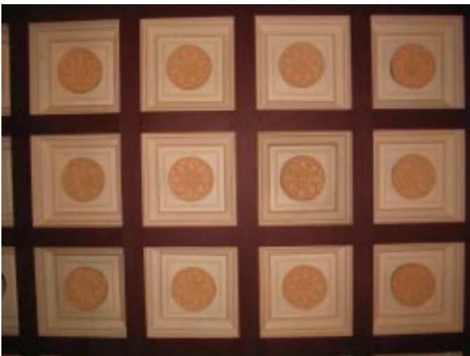
Figura 3.52: vista geral do fôrro de caixotões com estrutura metálica. Vista por baixo do fôrro em placas de Painel Wagner Wall, da Eternit.
