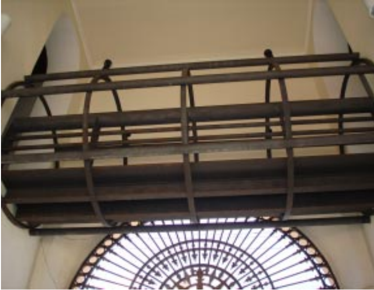
Figura 3.16: Passarela moderna ligando as duas torres , da torre malakoff.
