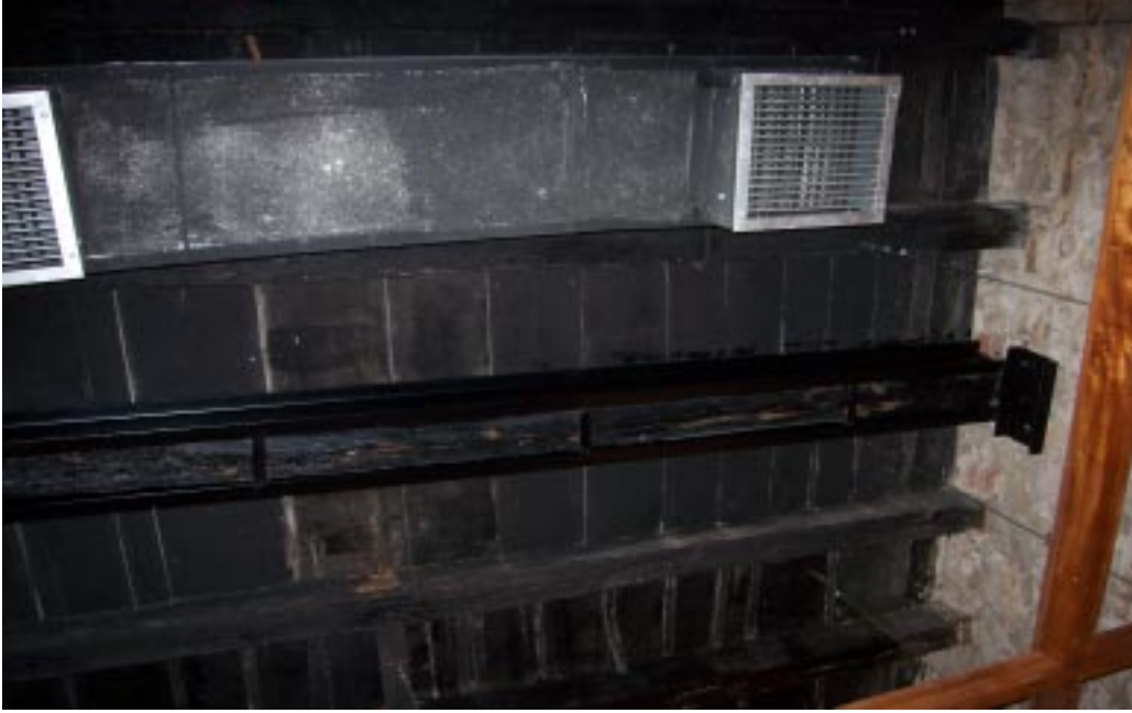
Figura 3.75: assoalho do pavimento superior vendo-se os dutos do ar-condicionado.
