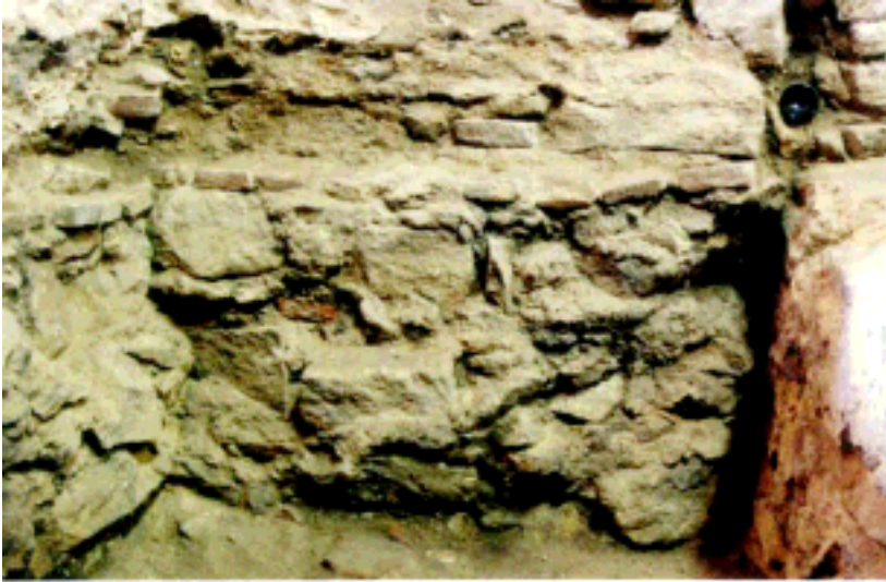
Figura 3.18 - Alicerce da sinagoga que se estendia até encontrar a antiga muralha da cidade. O contato sem amarração denota a anterioridade da muralha.
