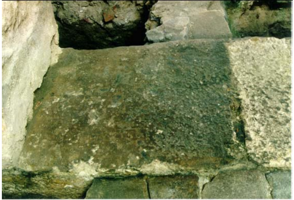
Figura 3.25 - Antiga soleira na porta de comunicação entre os cômodos 1 e 2 da casa 203. Posteriormente a porta foi deslocada para a direita e parte da soleira coberta pela nova parede. A porção mais escura demarca a antiga porta.
