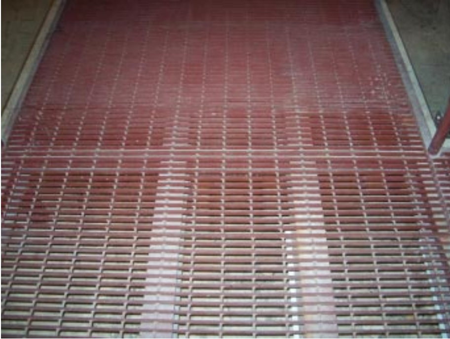
Figura 3.40: detalhe passarela em grelha metálica de aço.
