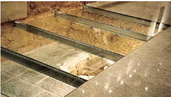
Figura 3.44: destaque para estruturas metálicas e pisos anteriores.
