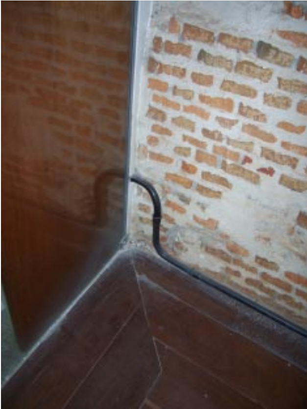
Figura 3.79: detalhe da instalação elétrica aparente.
