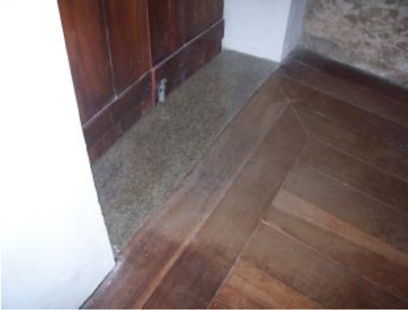
Figura 3.46: assoalho pavimento superior com soleira em granito. Transição para a laje do piso da varanda. Diferença de cota de 0.10 m.
