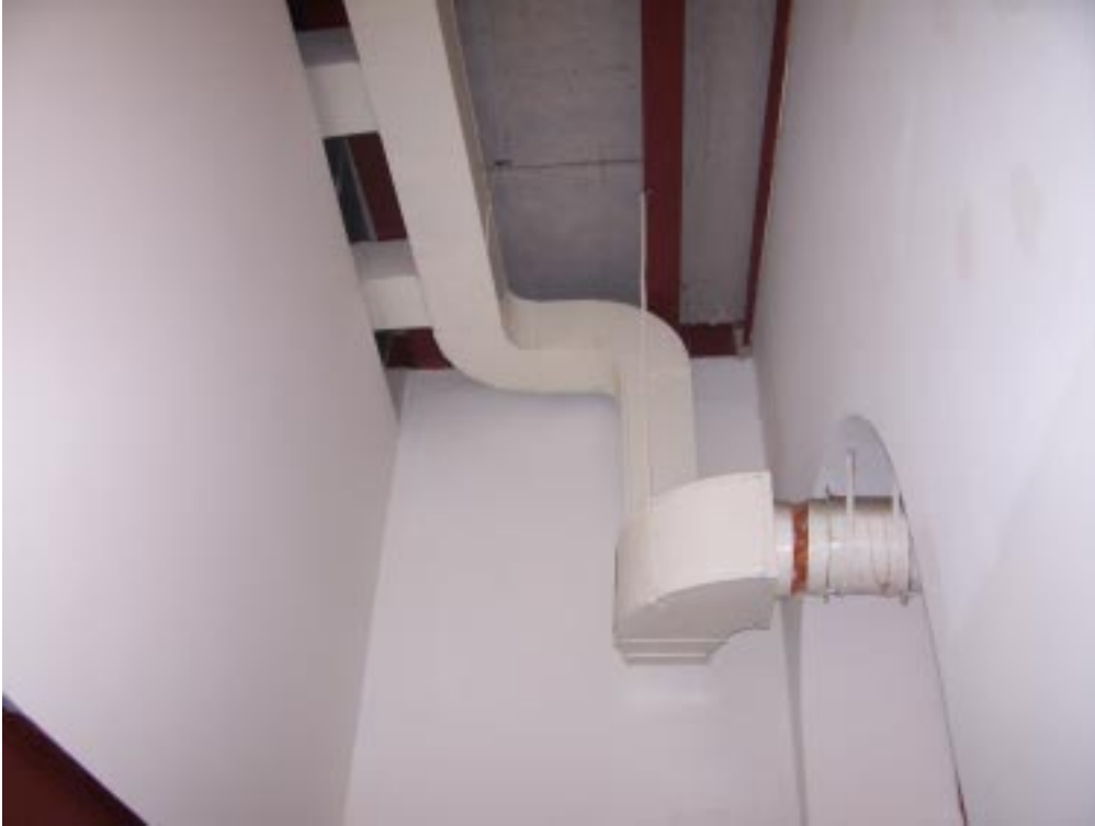
Figura 3.74: parte da distribuição dos dutos do ar-condicionado. Fonte: Carlos Alberto Cunha
