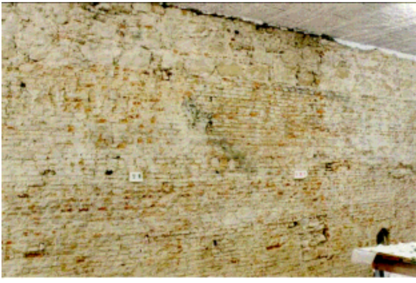
Figura 3.28 - Parede em tijolos, compartilhada entre a casa 203 e a vizinha à esquerda. Vê-se nos quadrantes superiores o contato entre os tijolos e a pedra, que revela a ampliação das casas.
