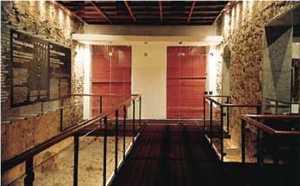
Figura 3.41: Passarela de grelha metálica permite ver os alicerces, os pisos anteriores e as paredes de pedra.
