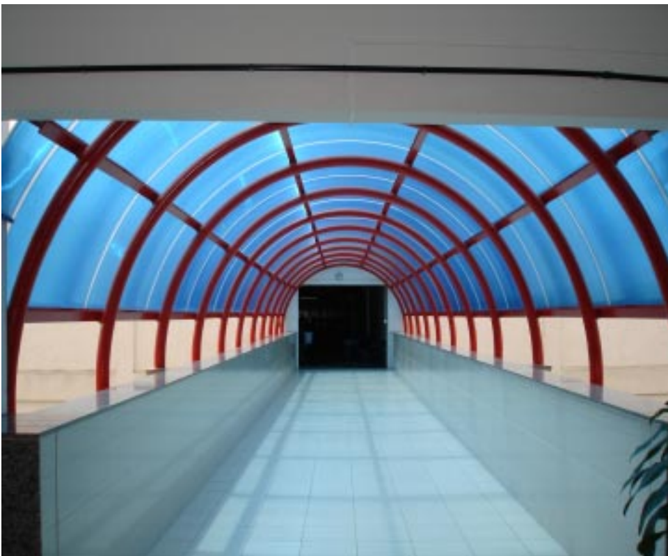
Figura 3.13: Perspectiva interna da passarela, acabamento do peitoril em granito polido Fonte: Carlos Alberto Cunha
