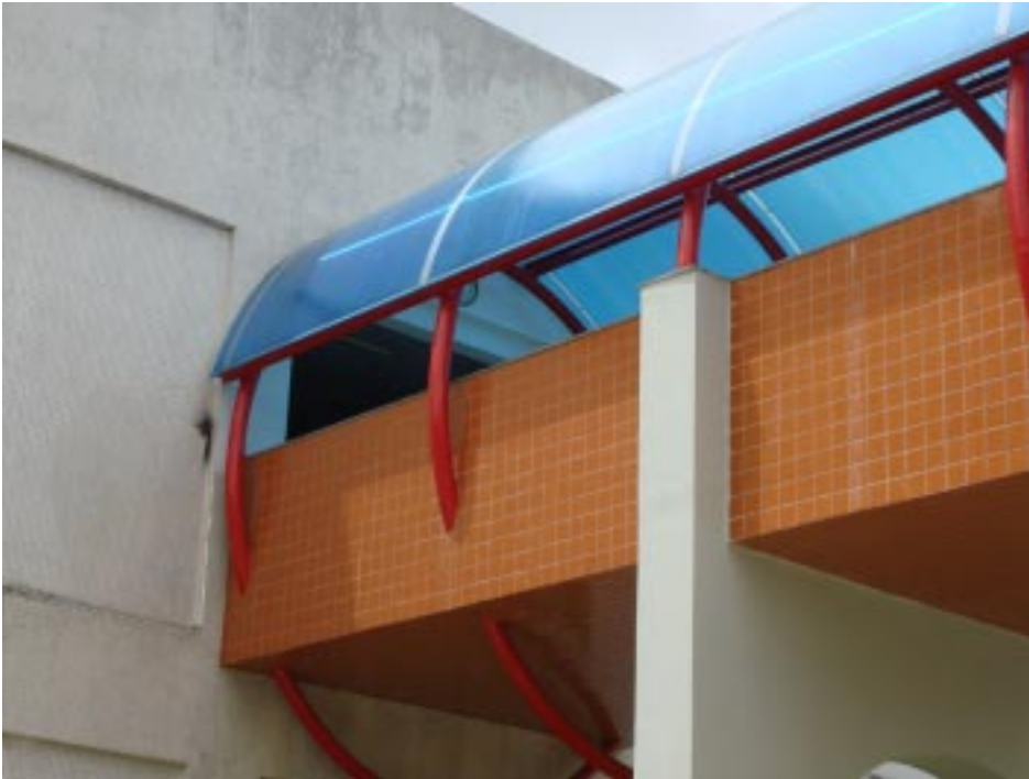
Figura 3.12: Detalhe da passarela, percebendo-se revestimento em cerâmica quadrada Fonte: Carlos Alberto Cunha
