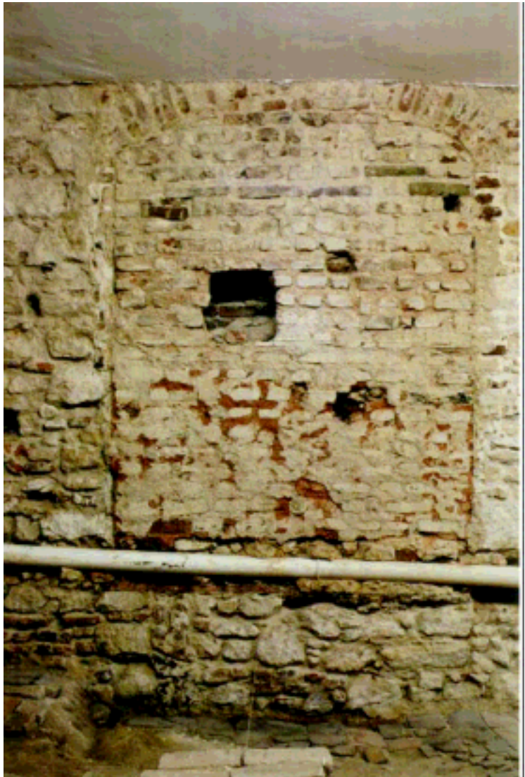
Figura 3.29 - Antiga porta de comunicação entre as casas 197 e 203 através do primeiro cômodo. Único acesso à época, a área posterior da casa 197, e ao mikvê.
