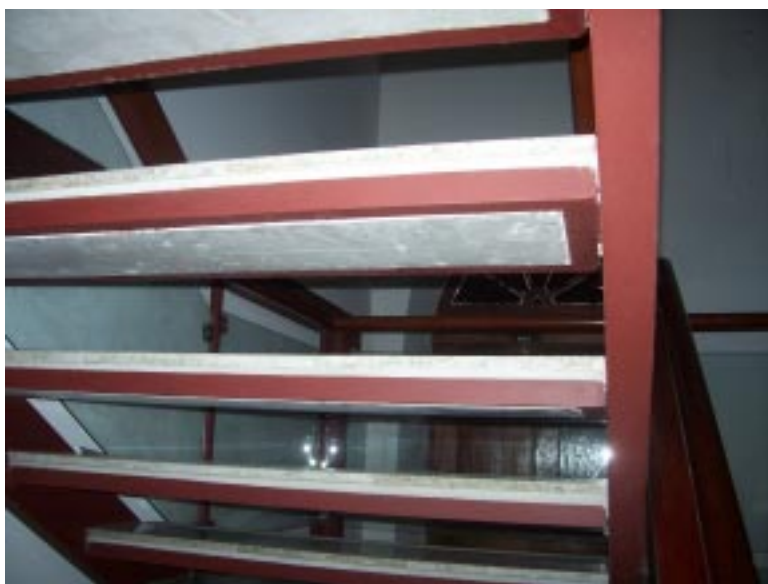
Figura 3.82: detalhe escada do mezanino.
