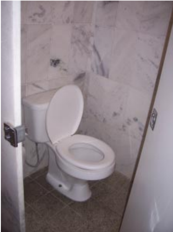
Figura 3.38: Interior do sanitário, vendo-se aplicação de mármore e granito.
