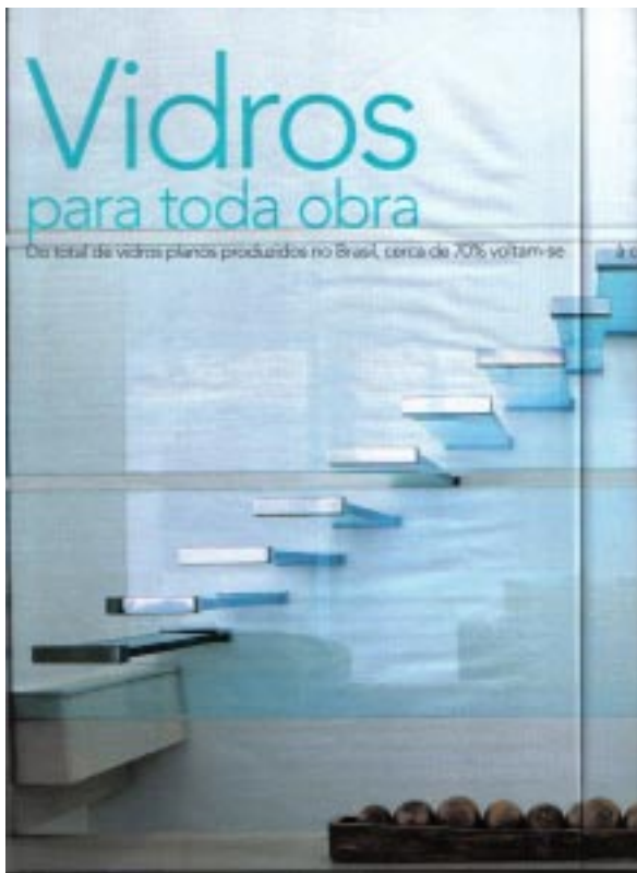
Figura 3.57: vidro laminado, com 30 mm de espessura.
