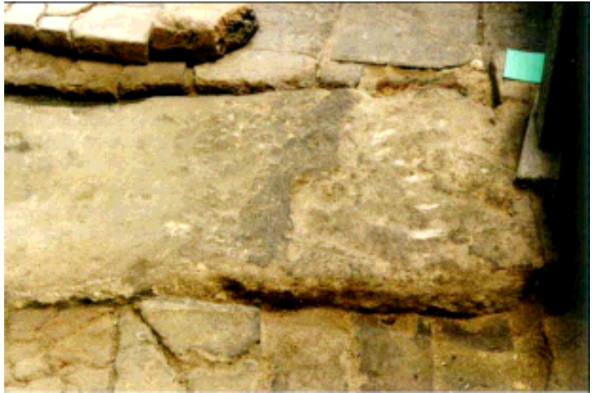
Figura 3.27 - Soleira de uma porta interna, entre os cômodos da casa 203. Vê-se no centro à direita, uma mancha escura que mostra o limite de um antigo portal removido, juntamente com a parede divisória.
