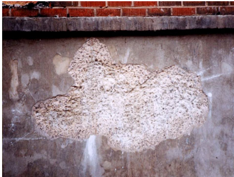
Figura 2.5 – Pipocamento (spalling) em uma superfície de concreto, devido ao incêndio, (INTERFIRE, 2007).
