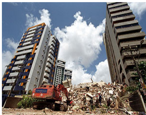
Figura 4.9 – escombros do Edifício Areia Branca.
