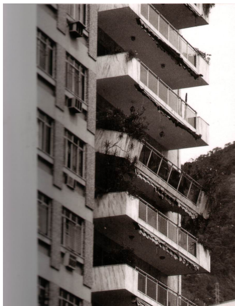
Figura 4.2 – Vista da fachada do prédio com a varanda do sexto andar inclinada (Jornal “O Globo” de 21/03/1993).
