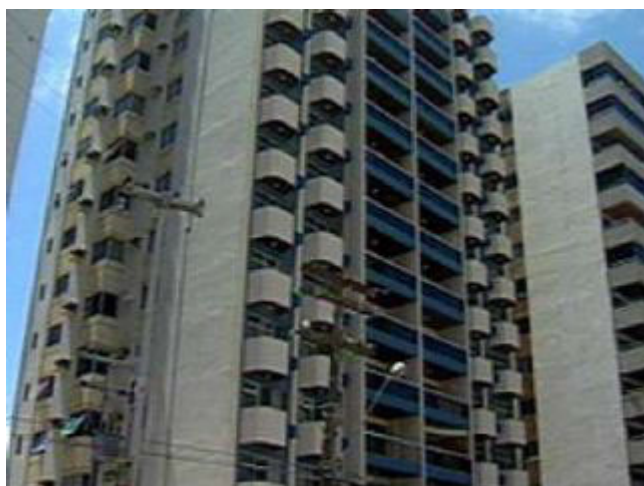
Figura 4.8 - Edifício Areia Branca, antes do desabamento.
