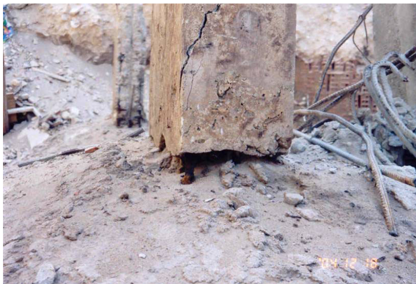
Figura 4.7 – Pescoço do pilar do Edifício Areia Branca – Recife (PE).
