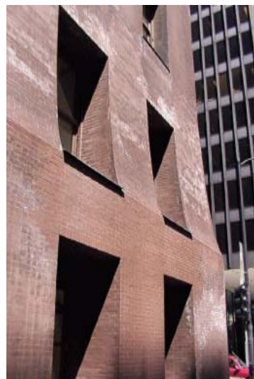
Figura 2.9 Edifício Monadnock Fonte: CARVALHO ROMAN, 2001
