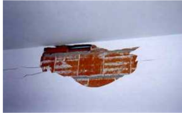
Deformação da estrutura por flexão
