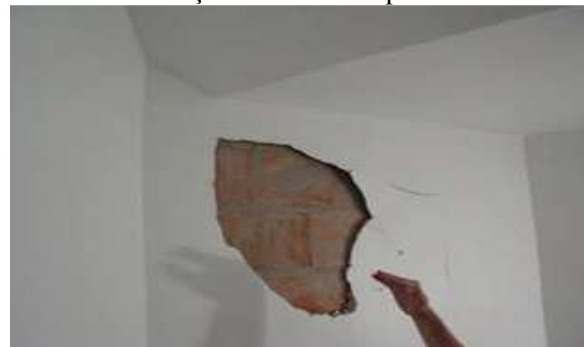
Encurtamento dos pilares
