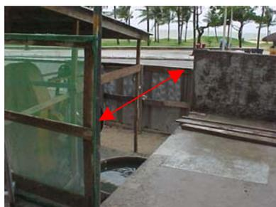
Solicitamos o fechamento do vão do PILOTIS através de proteção coletiva em sistema guarda-corpo e rodapé, conforme mostra foto abaixo.
