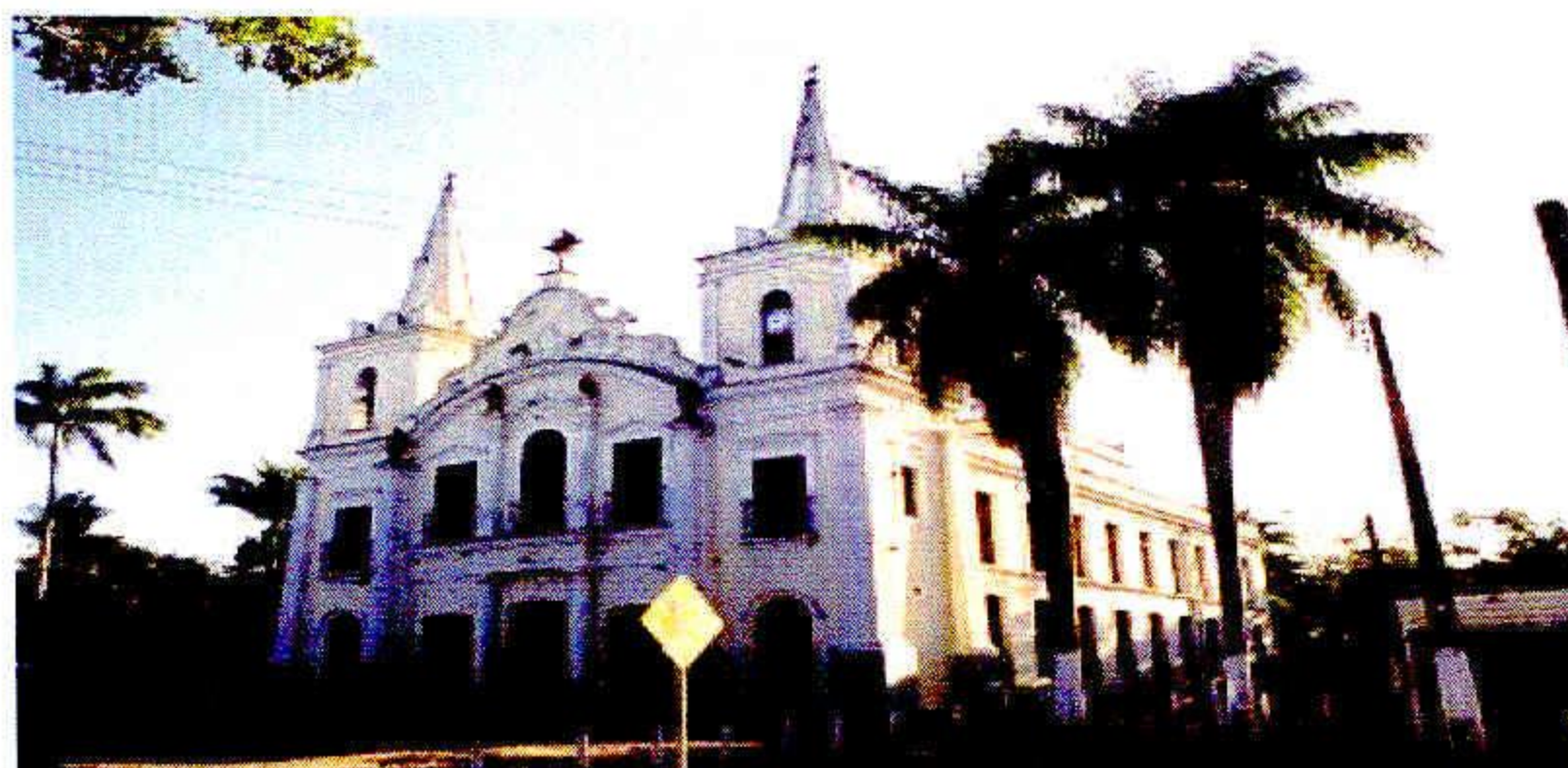
Figura 13: Capela de Nossa Senhora da Luz onde se encontra o Santuário de São Severino do Ramos.
