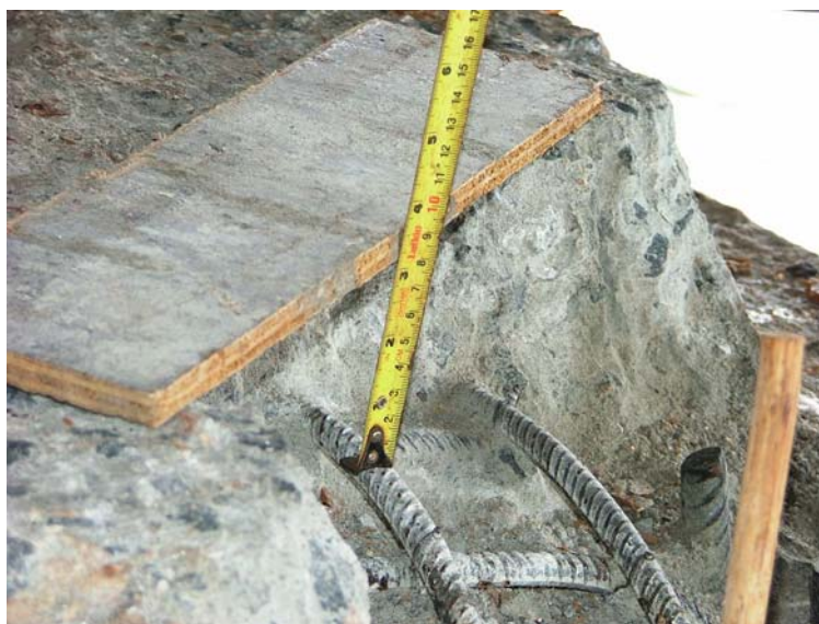
Figura 3.6 – Recobrimento da armadura superior do bloco
