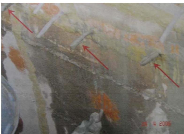
Figura 3.28 – Injeção e saída do microcimento pelos purgadores
