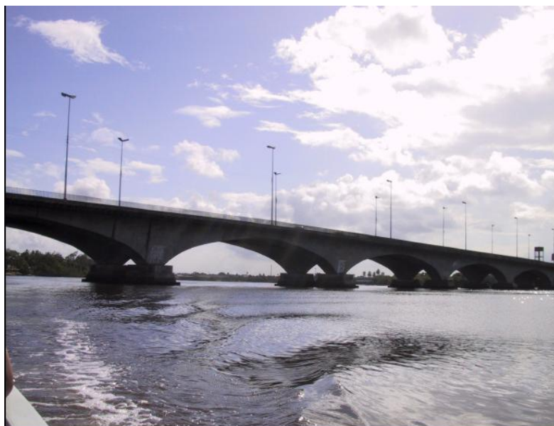
Figura 3.1 – Vista geral da Ponte Paulo Guerra
