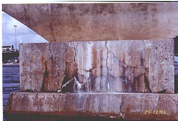
Figura 3.4 – Vista do bloco de apoio de um vão central.
