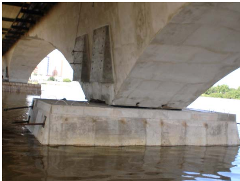
Figura 3.16 – Bloco e apoio prontos.
