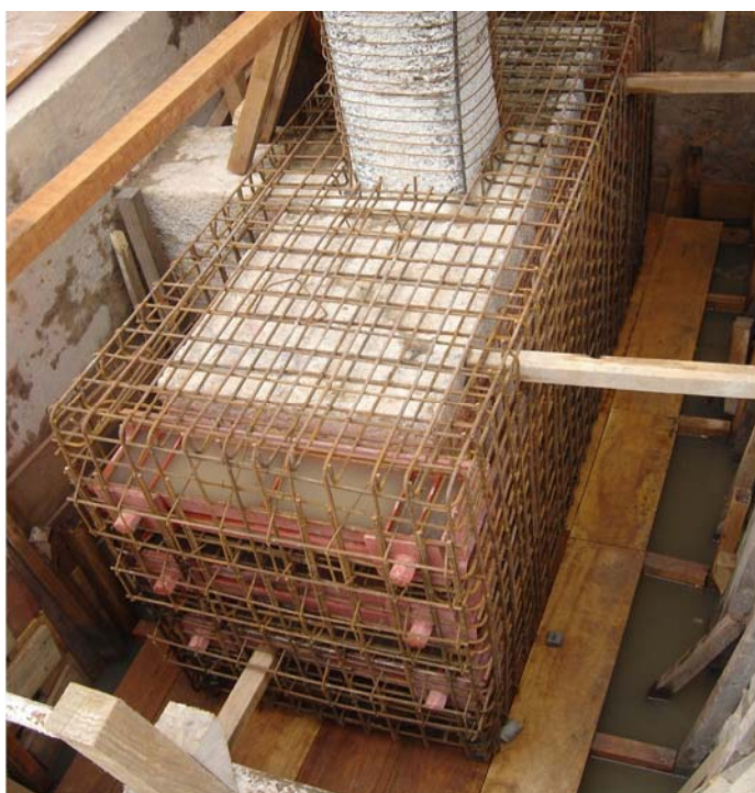
Figura 3.21 – Protensão em bloco de duas estacas. Fonte: Acervo do proprietário
