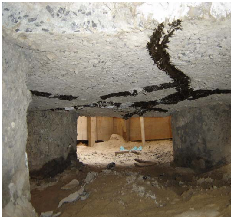
Figura 3.20 – Vista da face inferior de um bloco e da cabeça das estacas. Fonte: Acervo dos proprietários
