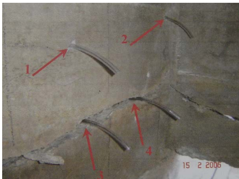
Figura 3.27 – Colocação de purgadores nas trincas, fissuras e furos
