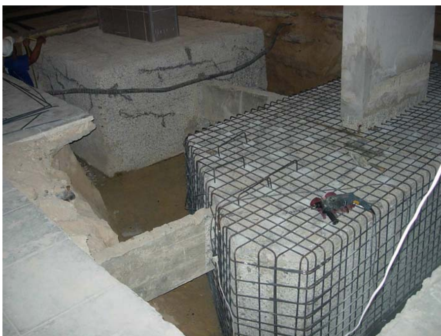
Figura 3.44 – Ferragem de reforço do encapsulamento do bloco, em fase de colocação
