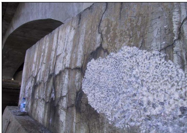
Figura 3.10 – Face lateral do bloco 10, lado do mar
