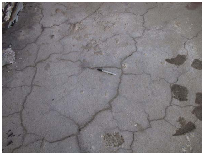
Figura 3.11 – Face superior do bloco 10, lado do mar
