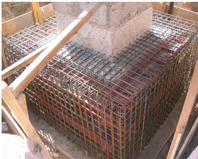
Figura 3.22 – Protensão em bloco de várias estacas.
