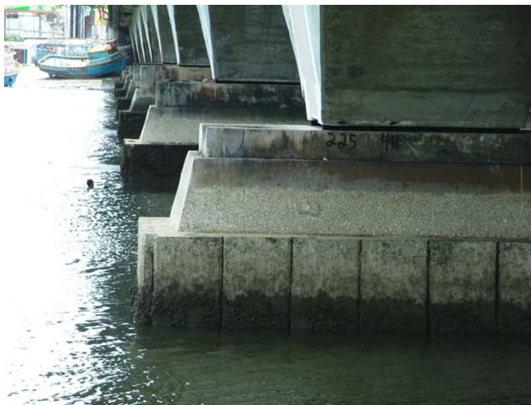
Figura 3.2 – Vista dos blocos, cálices, apoios e aparelhos de apoio
