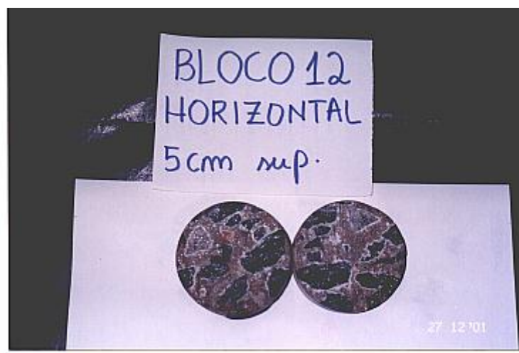
Figura 3.9 – Detalhe das auréolas brancas nas bordas dos agregados no Bloco 12.
