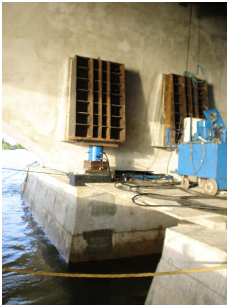
Figura 3.15 – Console metálico, sobre berço de regularização
