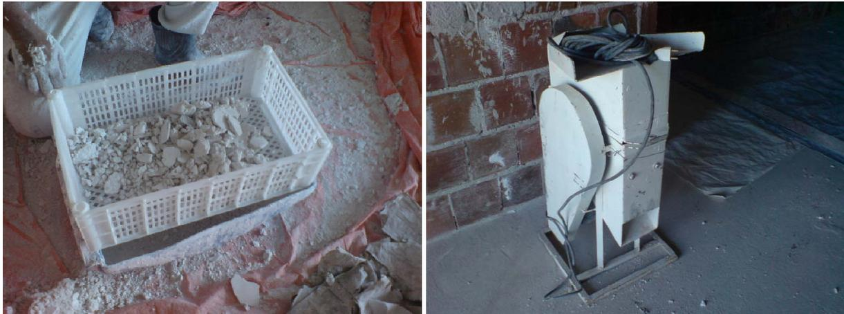
Figura 4.33 reaproveitamento do gesso na obra
