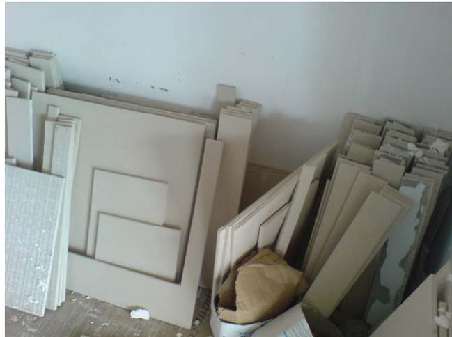
Figura 4.24 trinchos de cerâmica separados para reaproveitamento
