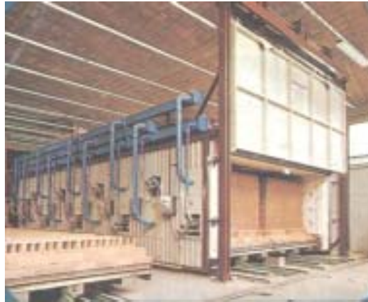
Figura 8 - Forno tipo túnel em uma indústria de cerâmica vermelha Fonte: GRIGOLETTI (2001)
