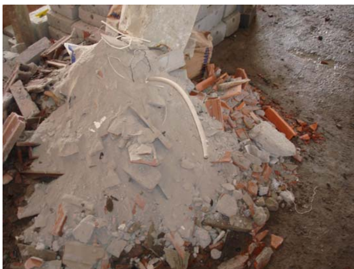
Figura 40 - Resíduos gerados na execução da alvenaria
