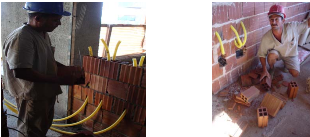
Figura 17 - Perdas de blocos cerâmicos na execução das instalações elétricas
