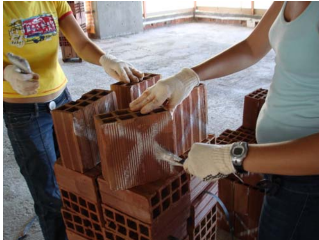
Figura 1 – Marcação de um lote de blocos cerâmicos a ser assentado
