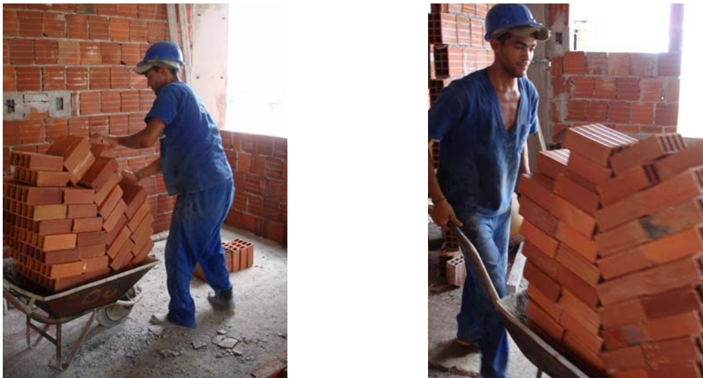
Figura 18 - Perdas de blocos cerâmicos no transporte até à frente de trabalho.
