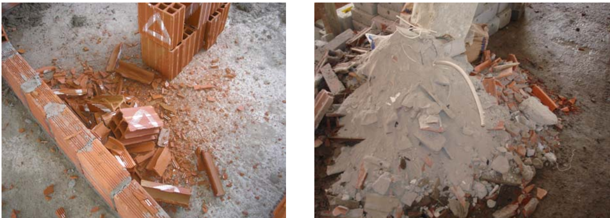
Figura 16 - Perdas de blocos durante a fase de execução da alvenaria de vedação
