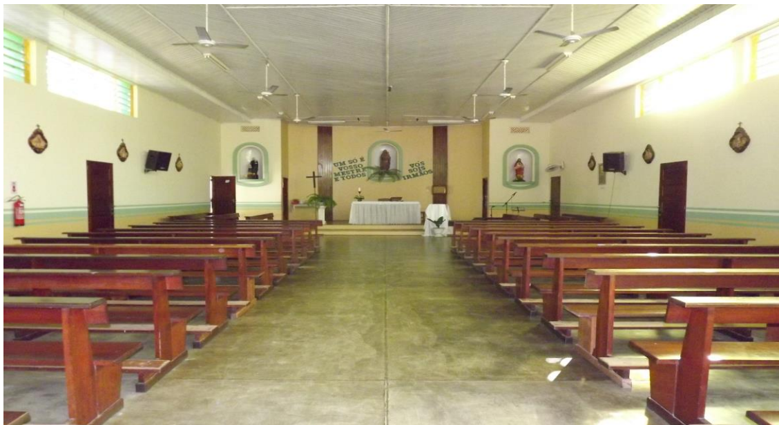
Imagem 9: Interior da mesma Igreja, antes da reforma.
