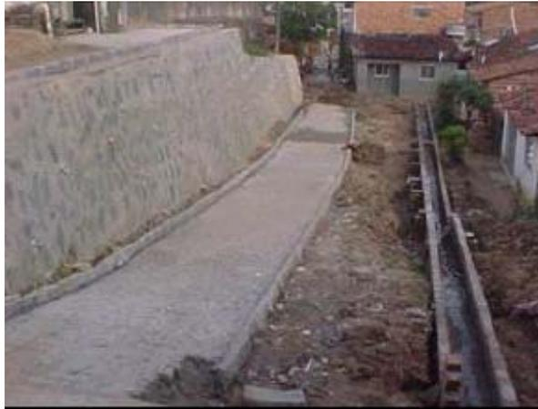
Figura II.4 - Muro de alvenaria de pedra - Arquivo da Profª. Vera Borges / UNICAP(2004).
