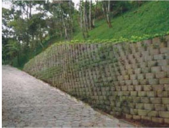
Figura II.5 - Muro de bloco de concreto articulado – encaixado sem rejunte (FIDEM, 2001).
