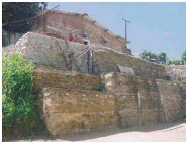
Figura II.2 - Muro de solo cimento ensacado - Rip-Rap (FIDEM, 2001).
